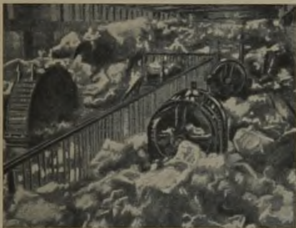
Rys. 1. Fragment hali maszyn elektrowni Ontario w czasie katastrofy lodowej.
