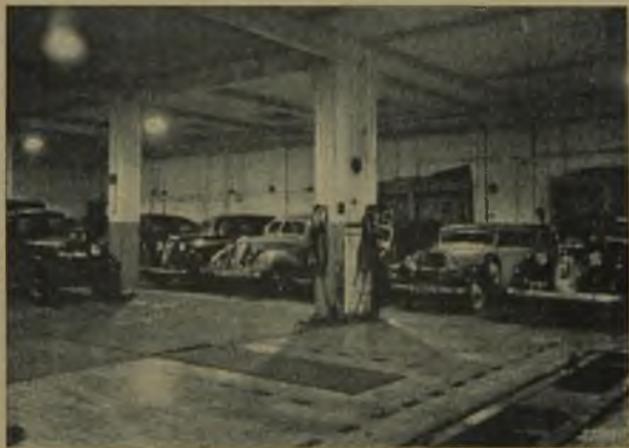
Rys. 67. Oświetlenie garażu w Hadze.
