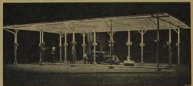
Rys. 66. Oświetlenie pośrednie stacji benzynowej.
