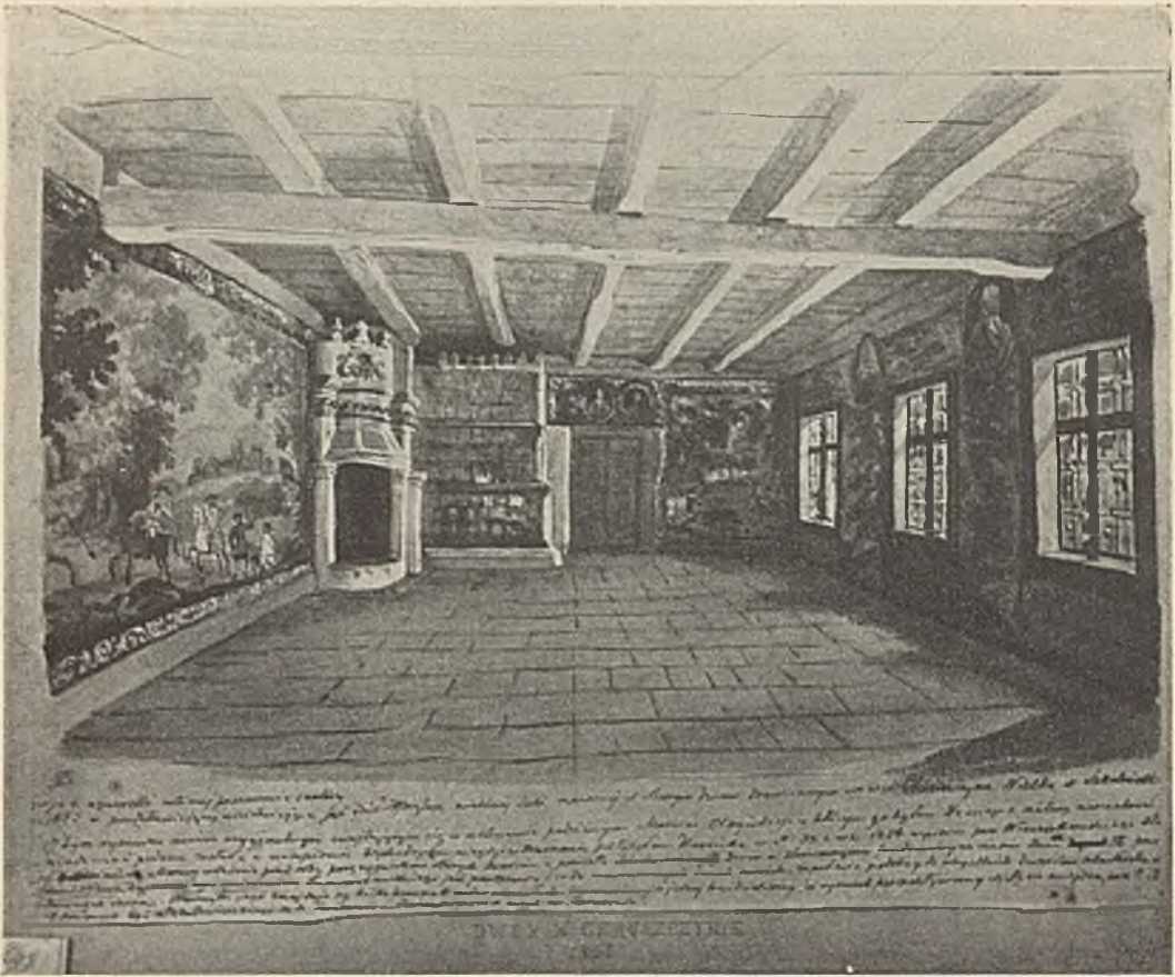
Fig. 167. Wojciech Gerson. Wnętrze drewnianego dworu w Chruszczynie Wielkiej. Kraków, Muzeum Narodowe.
