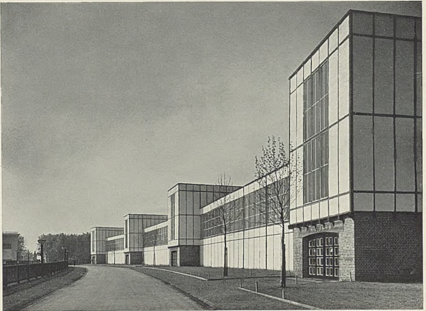
Die große, in leichter Kurve geführte Halle „Bauwesen“ von Architekt Klaus Reese, Düsseldorf. Schnitt 1:400
