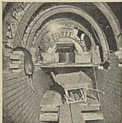
Rys. Nr 13. Budowa kanału.
