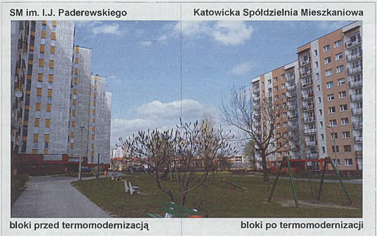
Fot. 49. Katowice, konfrontacja elewacji bloków będących pod zarządem dwóch różnych spółdzielni mieszkaniowych: bloki przed ociepleniem: SM im. I.J. Paderewskiego; bloki z ociepleniem: KSM
