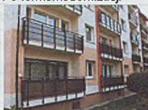
Remonty balkonów Os. Im. A. Zgrzebnioka
