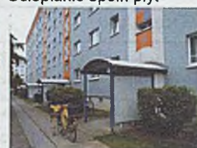
Po termomodernizacji Os. Grunau
