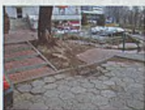
Wejście do budynku
