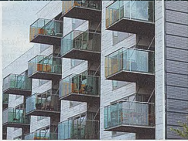
Wysoka jakość detalu balkonów
