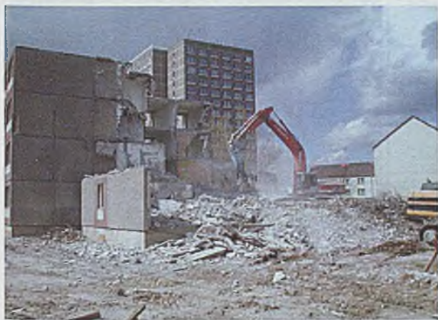
Fot. 52. Lipsk, Grünau, wyburzanie bloku Photo. 52. Lipsk, Grünau, demolition of a block of flats
