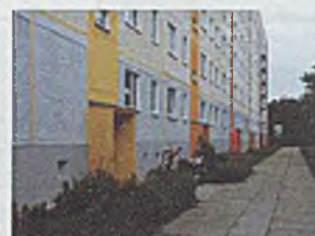
Ocieplanie spoin płyt
