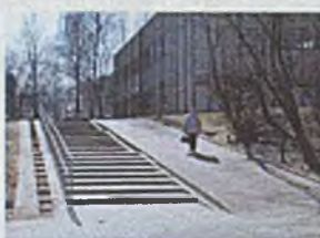
Schody terenowe z pochylnią
