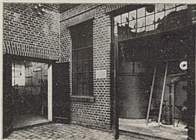
Abb. 29 Schweißerei-Neubau. Gasentwickelraum und Gasschweißwerkstätte.
