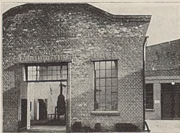
Abb. 31 Werkstattneubau von vorn.
