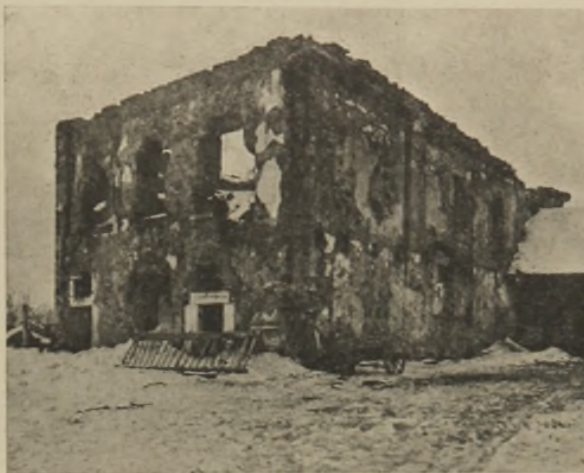
Fig. 14. Gorlice. Budowla t. zw. arjańska. Stan obecny.
