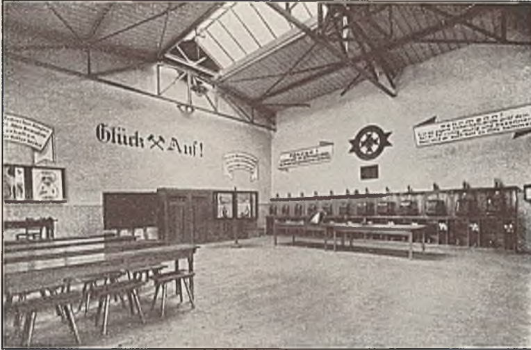
Abb. 24. Ludwigs-Glück-Grube, Geräteraum der Rettungsübungsstation
