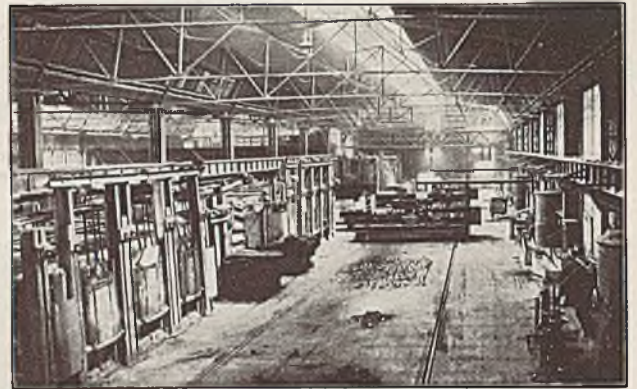
Abb. 40. Ofenbühne des S.-M.-Stahlwerkes
