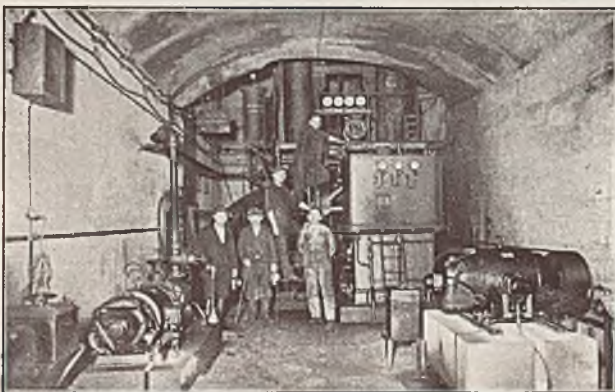
Abb. 12. Hochdruck-Mammut-Bagger-Anlage Arnoldschacht + 36-m-Sohle
