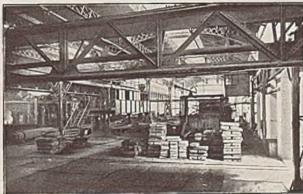
Abb. 45. Brammenlager und Stoßofen des Mittelblechwalzwerkes
