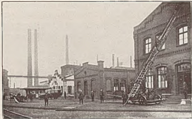
Abb. 86. Maschinenleiter und Krankenauto der Werkfeuerwehr
