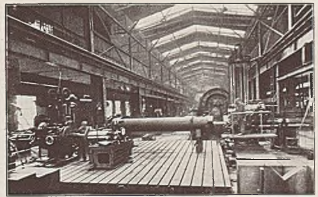
Abb. 71. 5800 mm langer Zylinder (Stahlguß) für die Ketten- rectmaschine auf der Spannplatte für 2 Horizontalbohrmaschinen
