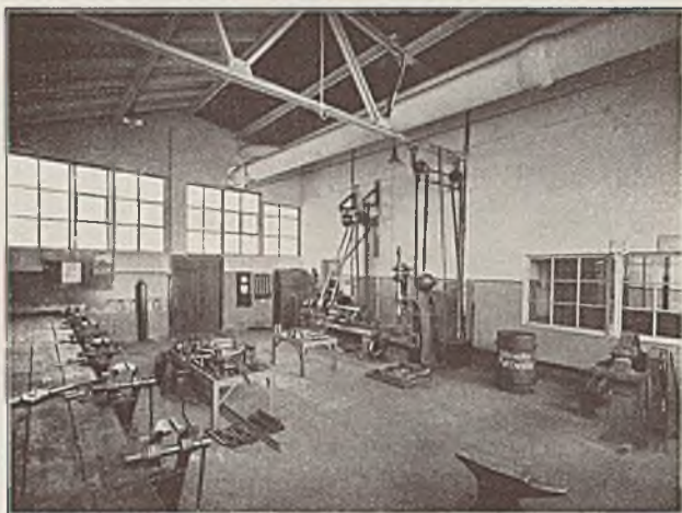
Abb. 79. Werkstättenbetrieb der Maschinenabteilung für Stahlwerk und Blechwalzwerk
