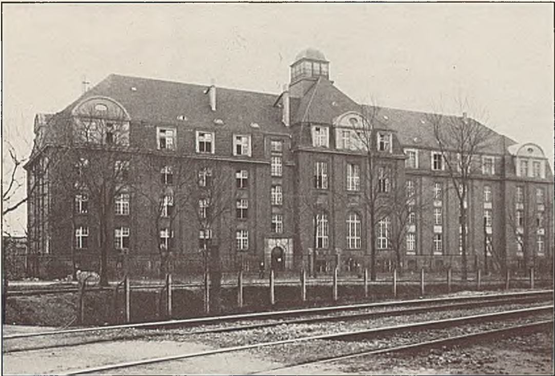
Abb. 111. Ledigenheim der Ludwig-Glück-Grube
