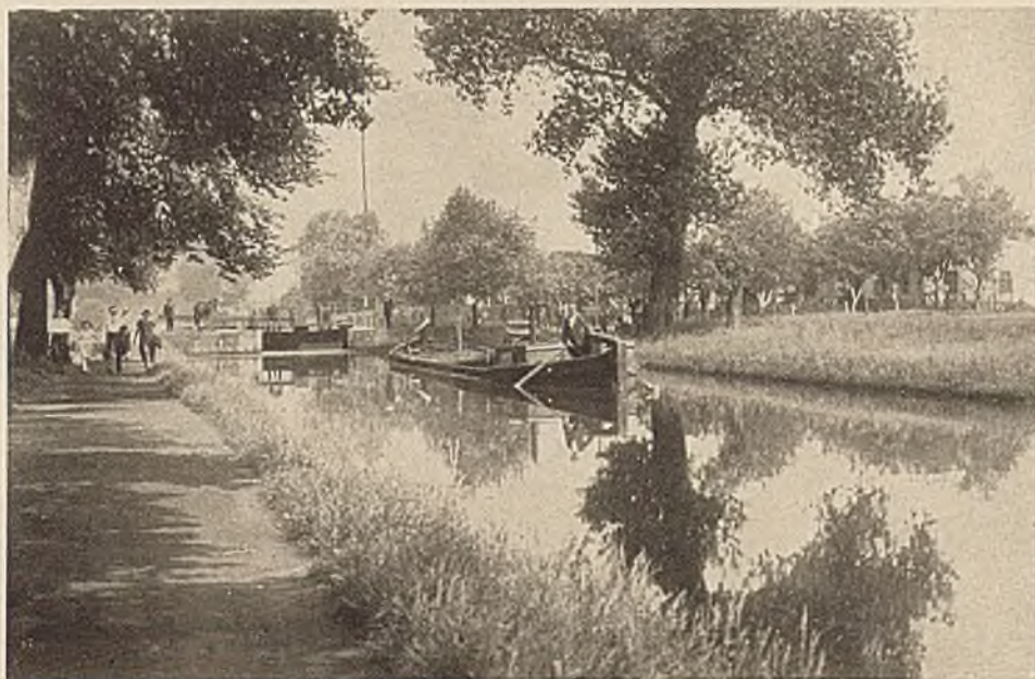
GLEIWITZ. KLODNITZKANAL. BLICKRICHTUNG AUF SCHLEUSE 17, PETERSDORF
