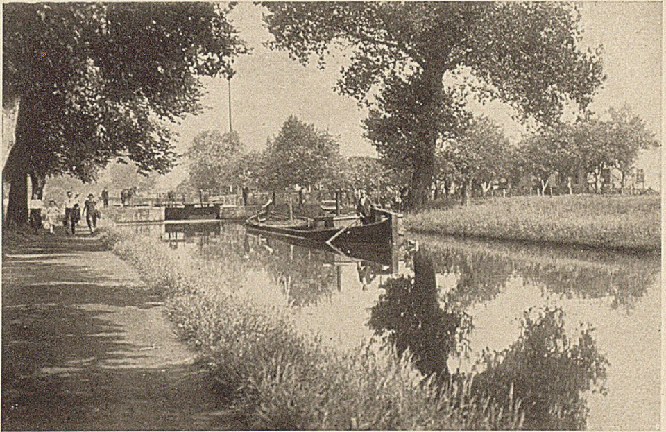
GLEIWITZ. KLODNITZKANAL. BLICKRICHTUNG AUF SCHLEUSE 17, PETERSDORF
