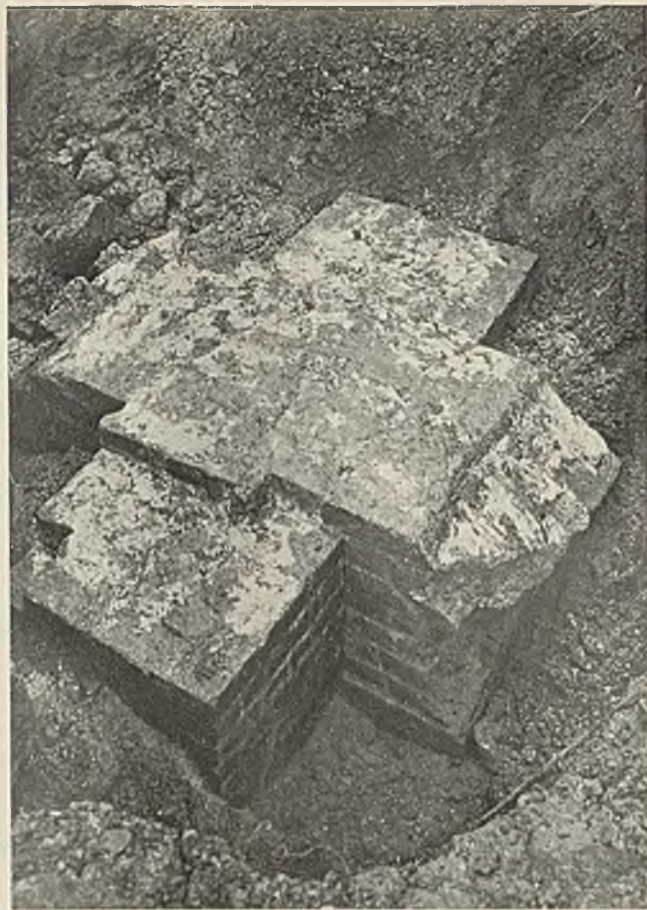
Abb. 12. Kreuzpfeiler mit den Anfängen der Bogen-Widerlager. Fundstelle E, von NW gesehen.
