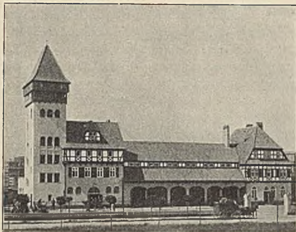
Abb. 8. Feuerwehrdepot der Donnersmarckhütte in Zabrze.
