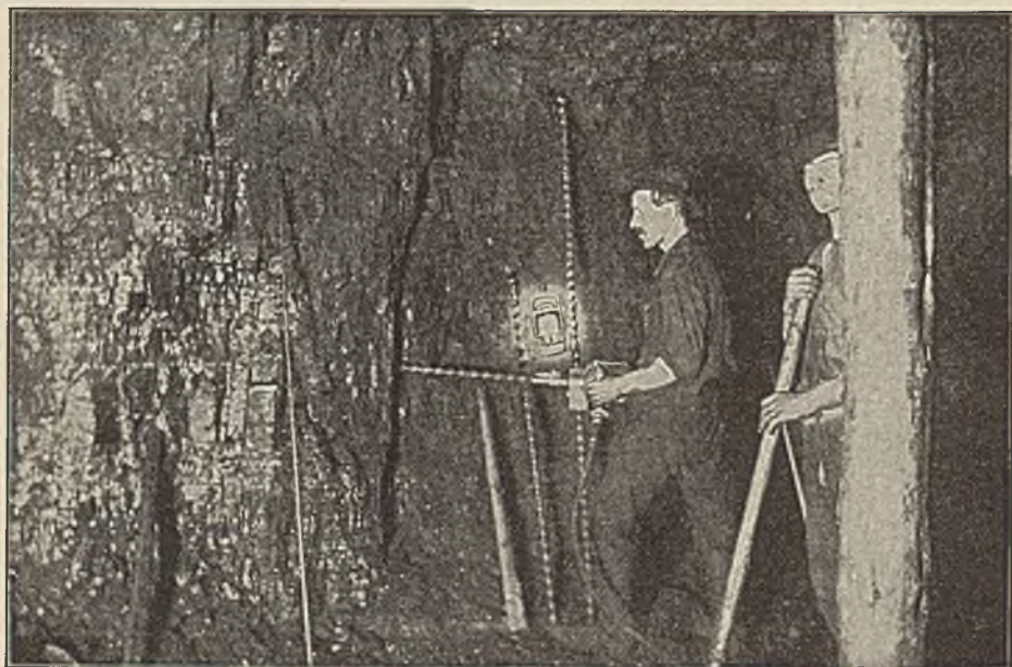
Abb. 41. Elektrische Bohrmaschine der Schlesischen Gruben- und Hüttenbedarf-Gesellschaft im Betriebe.
