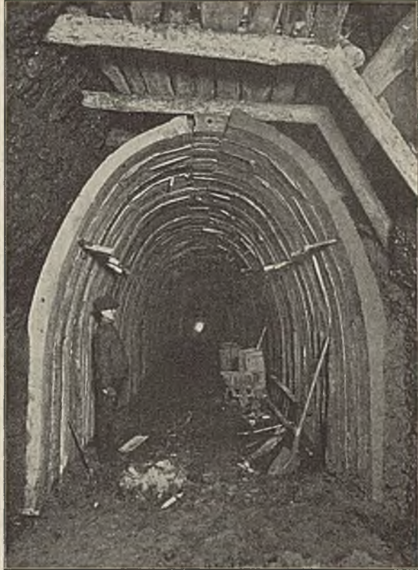
Abb. 49. Streckenausbau aus Eisenbeton.
