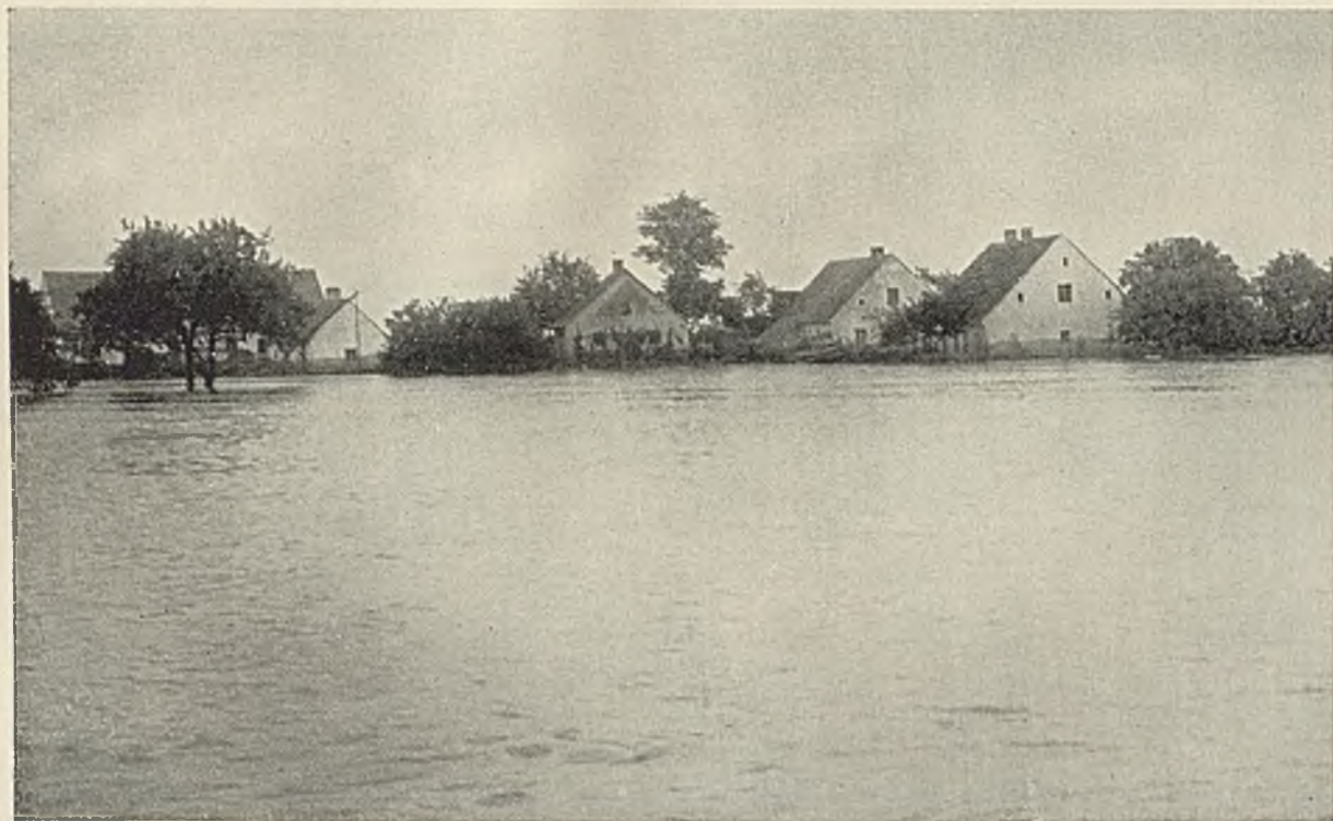
Hochwasser 1903. Kanjern von der Oberseite.
