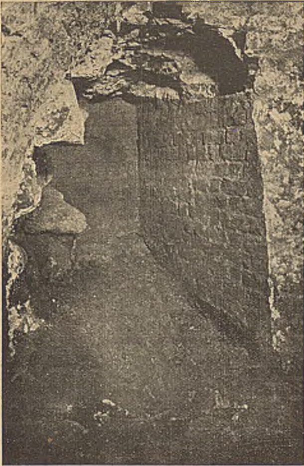
Zamek królewski w Warszawie. Epoka ks. Mazowieckich. Mur piwnicy pod salą o 2 słupach od strony Baszty Grodzkiej.
