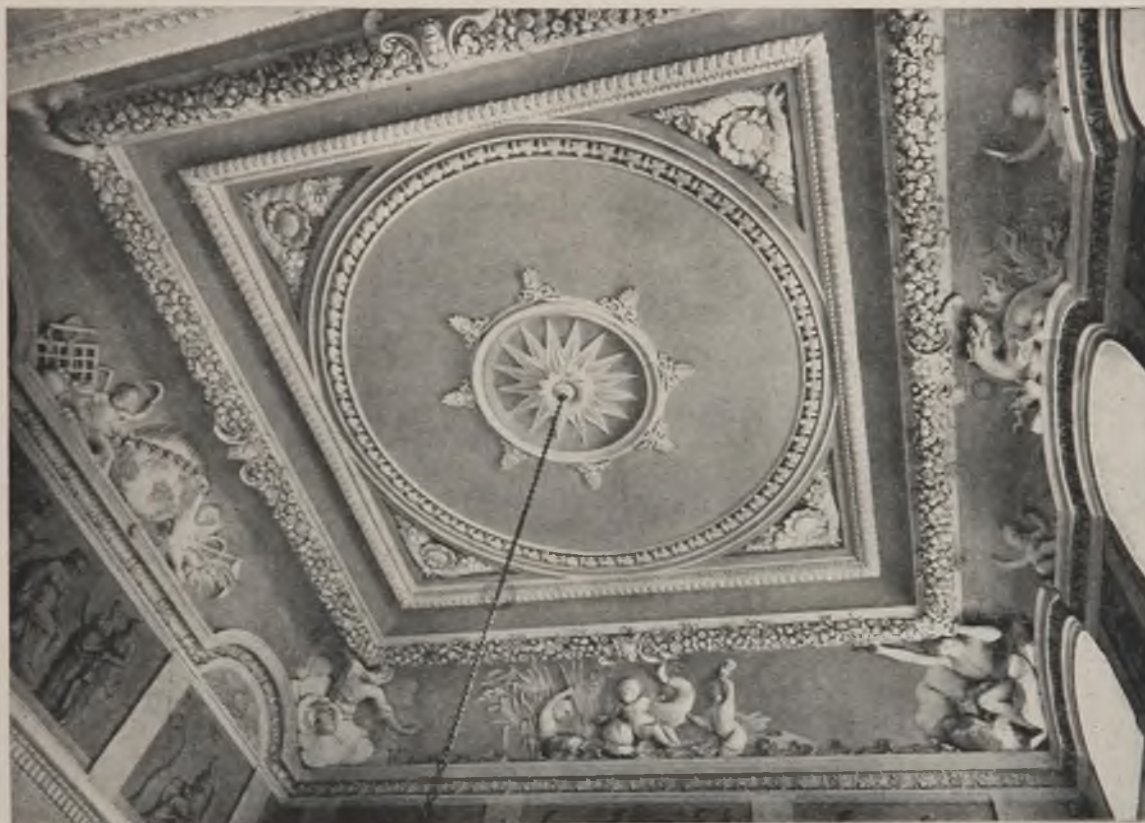
3. Wilanów, plafon sali stołowej.
