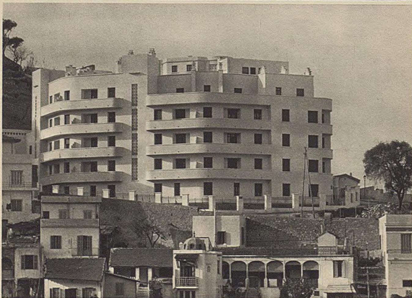
En haut : H. B. M. M. FERLIE, Architecte ; Fores GARCIA, Constructeurs Métalliques. En bas : Cité ouvrière. M. FERLIE, Architecte ; Ateliers DURAFOUR Constructeurs Métalliques.
