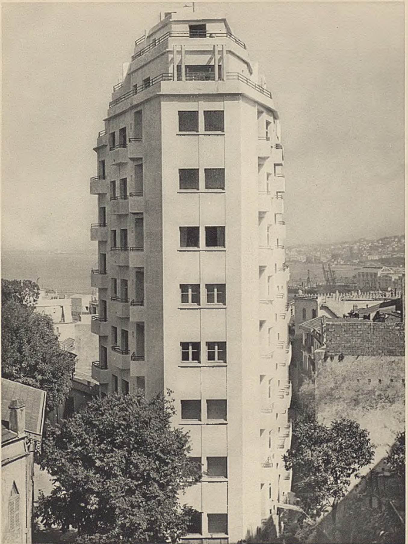
Immeuble terminé. M. VOIRON, Architecte ; PAINDAVOINE Frères, Constructeurs Métalliques.
