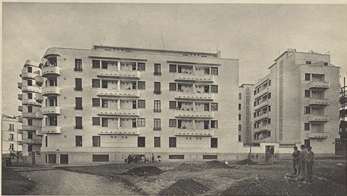
Immeubles de logement, Groupe des Anciennes Messageries ; M. FERLIE, Architecte ; OMNIUM d'ENTREPRISES, Constructeurs Métalliques. Photo EICHACKER,
