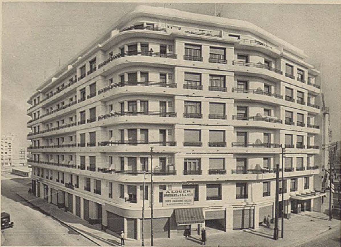
Ossature en acier. M. PREUILH, Architecte : Ateliers DURAFOUR, Constructeurs Métalliques. Immeuble terminé. M. PREUILH, Architecte : Ateliers DURAFOUR, Constructeurs Métalliques.
