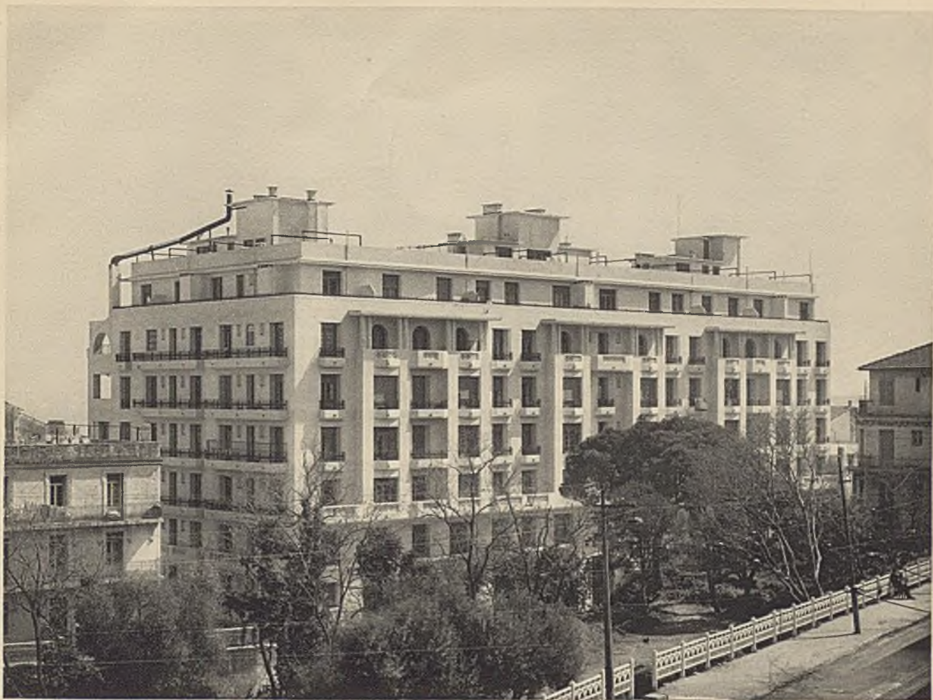
N. PREUILH, Architecte : Michel PANDOLFO, Constructeur Métallique.
