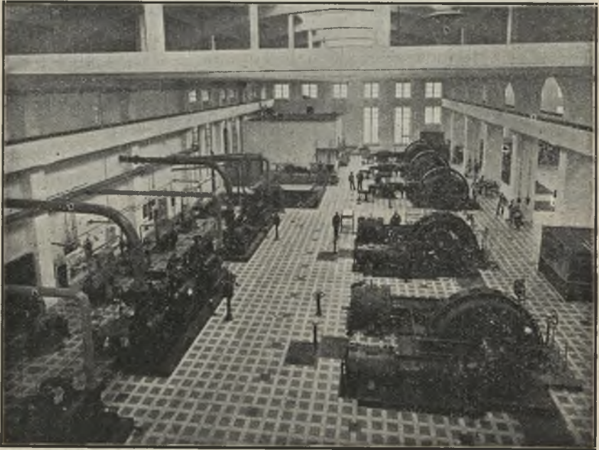
Ryc. 98. Hala kompresorów oddziału Lindego.
