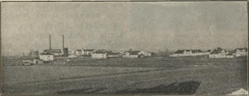
Ryc. 90. Ogólny widok fabryki nawozów sztucznych w Mościcach od strony południowej.
