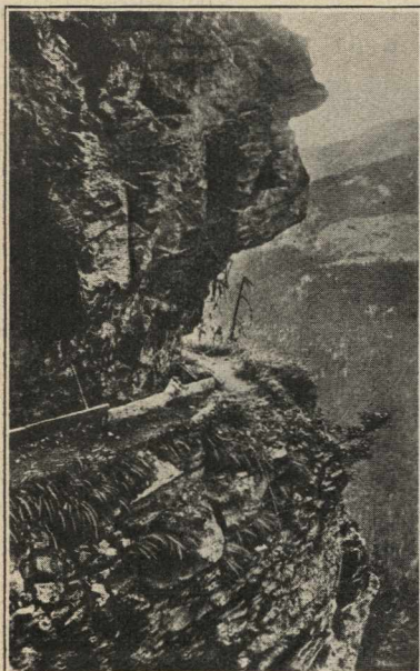
Ryc. 4. Bisse de Lyton albo de Roh. Miejsce przebudowane na podłużną galerię ze ścieżką dla kontroli.
