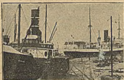
Ryc. 44. Fragment portu handlowego.
