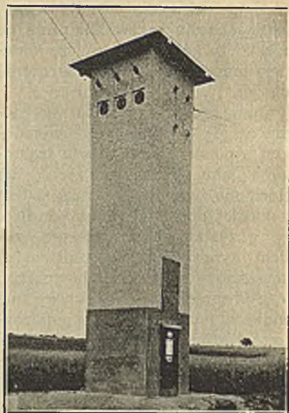
Ryc. 209. Budka transformatorowa dla zasilania prądem oświetleniowym.
