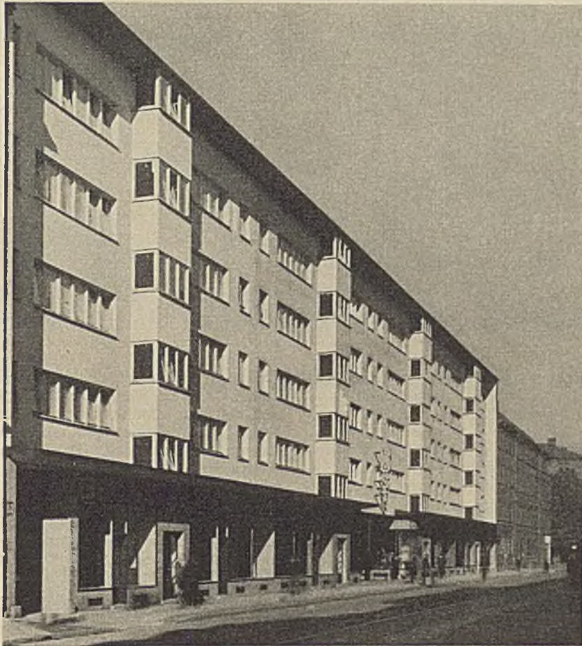
Postamt an der Fraunhofer Straße in München. Straßenansicht.
