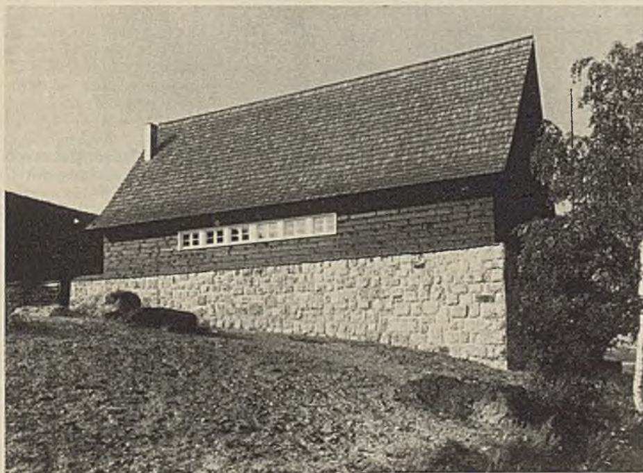
Südwestansicht des Nebengebäudes.
