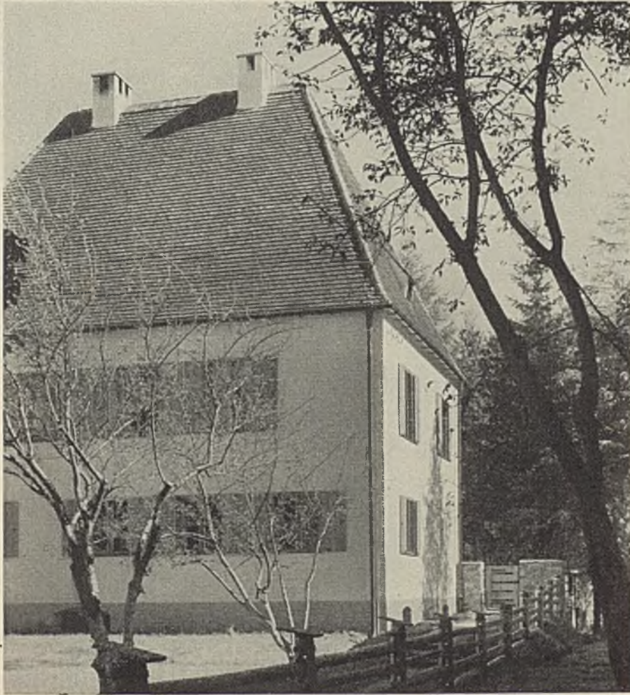
Postamt in Pfronten-Ried, Gartenseite.
