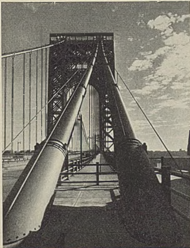
Abb. 5. Brückenportal mit Rückhaltekel.
