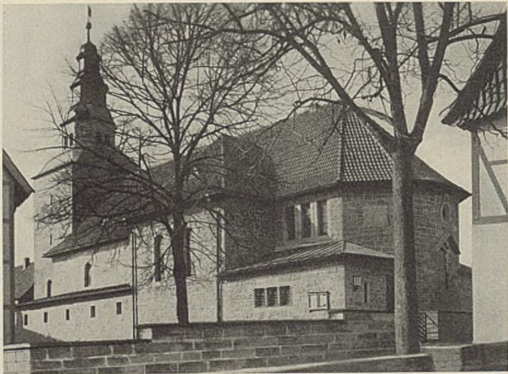
Südostansicht der Kirche.
