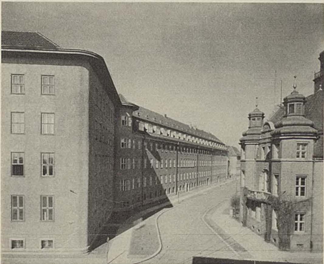
Händelstraße mit Gerichts- und Gefängnisweiterungsbauten.
