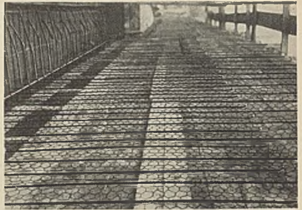
Abb. 4. Anwendung der Benzinger-Bauweise bei einer großen Stützmauer zur Sicherung der Hänge am Schloßberg bei Udenheim.
