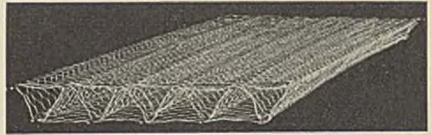
Abb. 11. Die räumliche Benzinger-Bewehrung.
