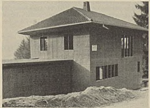
Abb. 10. Landhaus in Bad Liebenzell (Württ.) in Benzinger-Bauweise.
