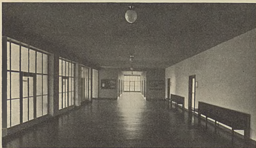
Halle und Flur im dritten Obergeschoß.
