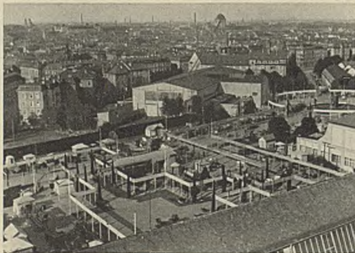
Straßenbauausstellung in München, Freigelände.
