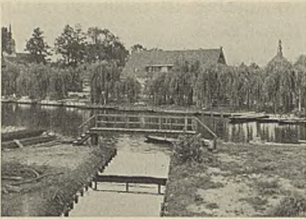
Abb. 2. Fußgängerbrücke über einen Entwässerungsgraben. Der Graben dient gleichzeitig dem Wirtschaftsverkehr.
