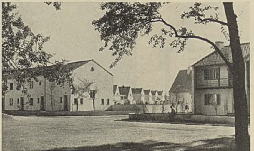
Reihenhäuser an der Neubauerstraße.
