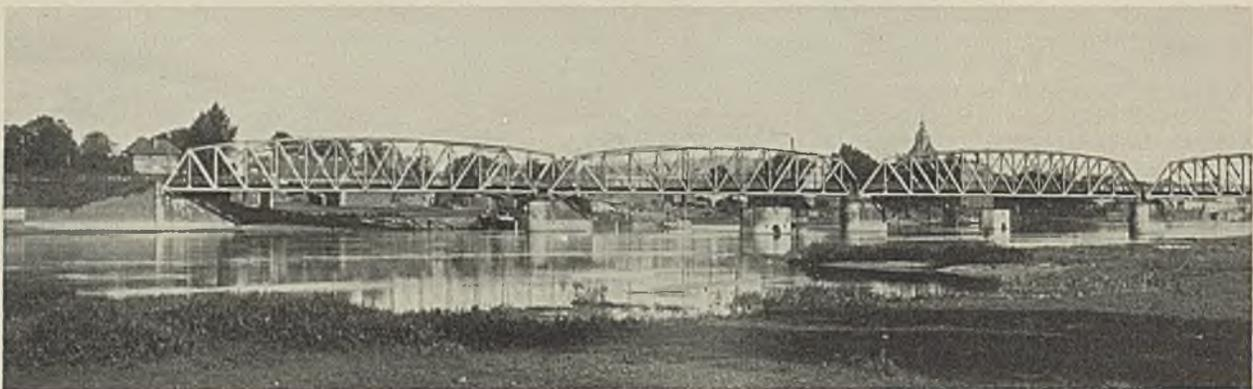
Abb. 28. Eisenbahnbrücke über die Warthe bei Landsberg (mit Mastenkranpfeilern ober- und unterhalb).  $z = 6$ ,  $L = 289$  m.
