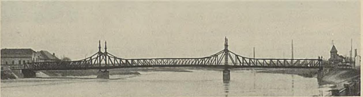
Abb. 9. Straßenbrücke in Ohlau. Gerberträger. 1898/1900.  $z = 3$ ,  $L = 150$  m.
