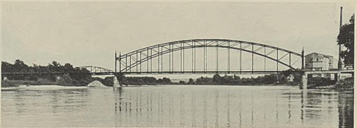
Abb. 18. Straßenbrücke bei Beuthen. *Parabel-, Halbparabelträger und I-Eisen in Beton (Überführung). 1906.  $z = 13 + 13$  (Überführung),  $L = 616$  m.*
