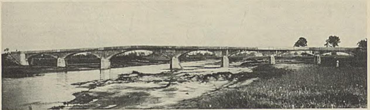
Abb. 3. Straßenbrücke bei Schichowitz. Eisenbeton. 1922/24.  $z = 7$ ,  $L = 172$  m.
