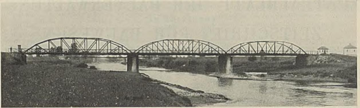
Abb. 2. Straßenbrücke bei Olsau. Schweißler-Träger. 1878/79. Anzahl der Öffnungen  $z = 3$ , Gesamtlänge  $L = 107$  m.
