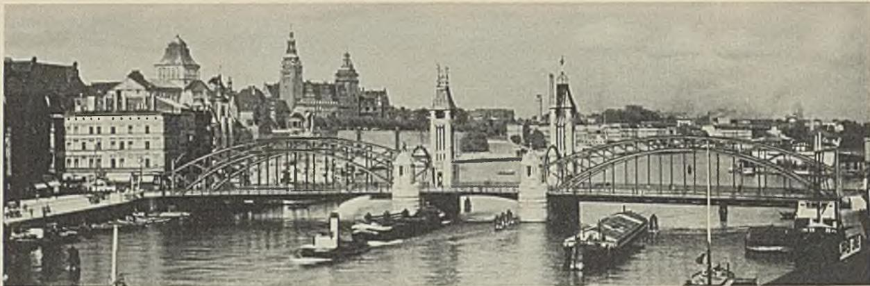
Abb. 27. Straßenbrücke in Stettin (Baumbrücke). Eiserner Fachwerkhogen mit Klappe.  $z = 3$ ,  $L = 124$  m.
