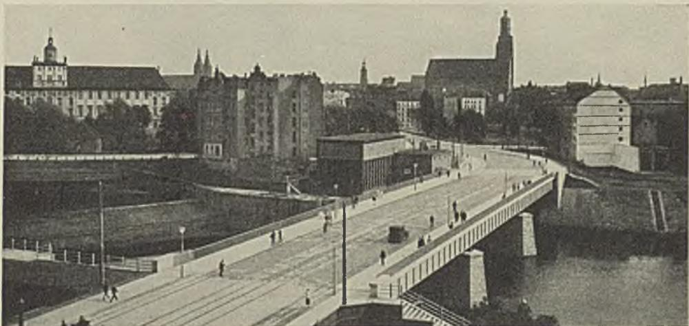
Abb. 12. Straßenbrücke in Breslau (Werderbrücke). Durchlaufender Träger. 1929/30.  $z = 3$ ,  $l = 90$  m.
