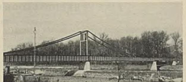
Abb. 4. Fußgängerbrücke in Oppeln (Bolkobrücke). 1931/32.  $z = 4$ ,  $L = 195,5$  m.
