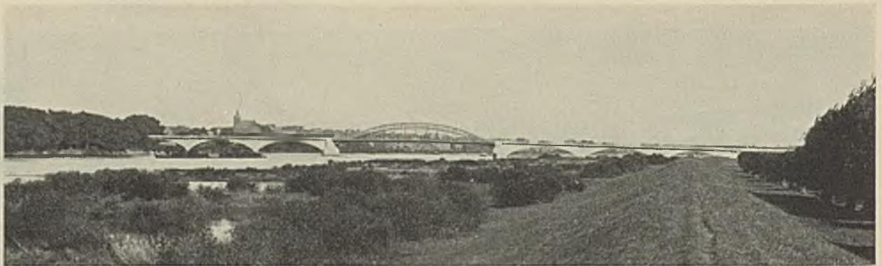
Abb. 21. Straßenbrücke bei Fürstenberg. Eisenbetonbogen und eiserner Sichelstahlträgerbogen. 1914/19. z = 12, L = 618 m.
