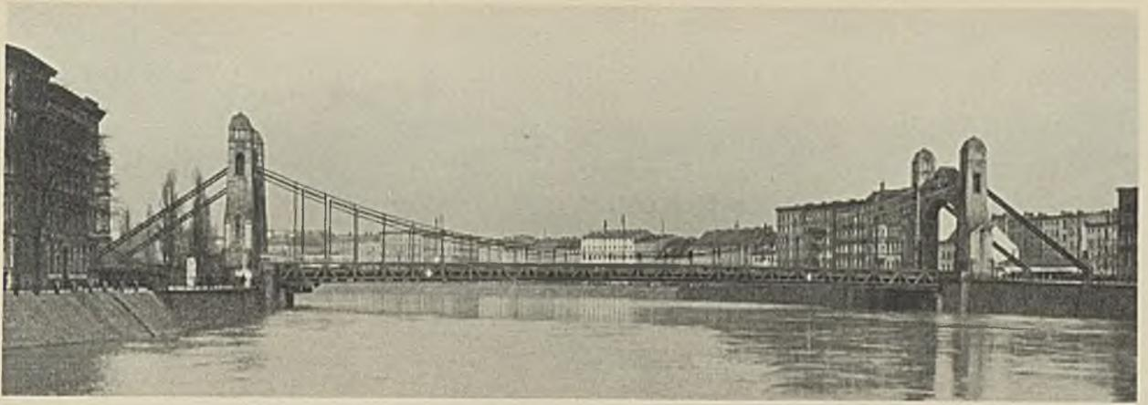
Abb. 11. Straßenbrücke in Breslau (Kaiserbrücke). Hängebogenträger. 1917.  $z = 1$ ,  $l = 187$  m (Lichtweite = 112,5 m).
