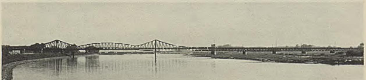
Abb. 16. Straßenbrücke in Steinau. Gerberträger. 1896.  $z = 8$ ,  $L = 349$  m.
