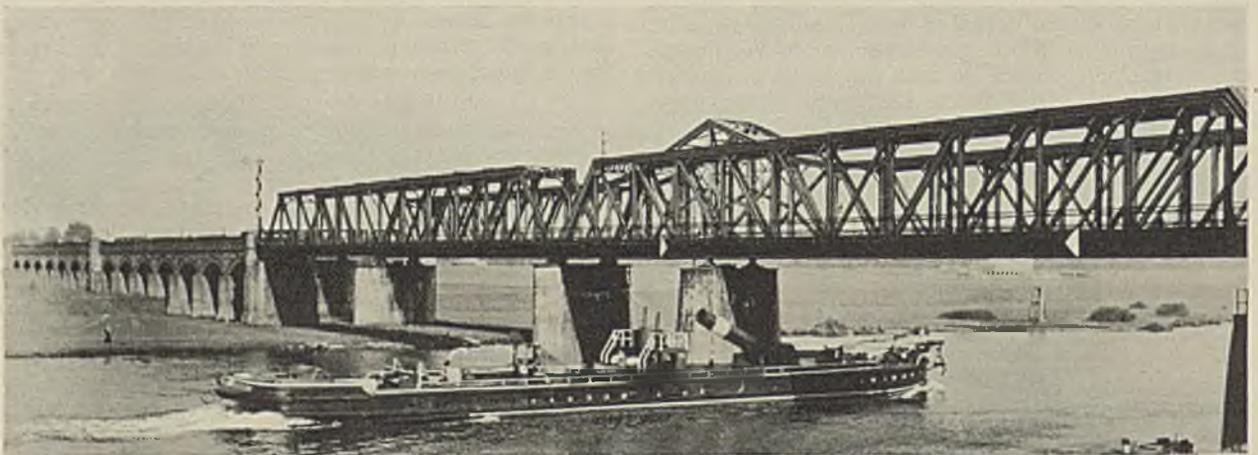
Abb. 15. Eisenbahnbrücke in Pöpelwitz bei Breslau. Vordere Brücke: Trapezträger und Gewölbe. 1898 bzw. 1856.  $z = 2+28$ ,  $L = 455$  m.
