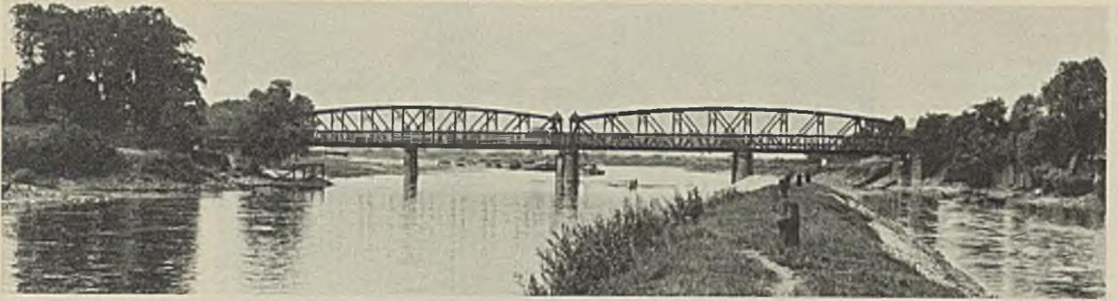
Abb. 17. Eisenbahnbrücke in Glogau. *Vordere Brücke: Parallelgitterträger. 1857/58.  $z = 6$ ,  $L = 166$  m.*
