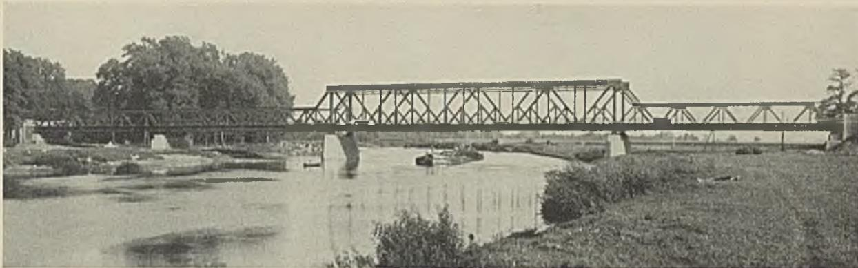
Abb. 5. Eisenbahnbrücke in Oppeln. Gelenkfachwerkträger. 1927/28.  $z = 4$ ,  $L = 178$  m.
