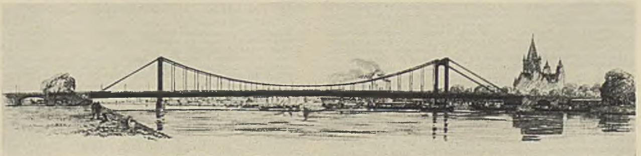
Abb. 3. Die neue Kettenbrücke. Spannweite der Mittelöffnung 241,2 m.
