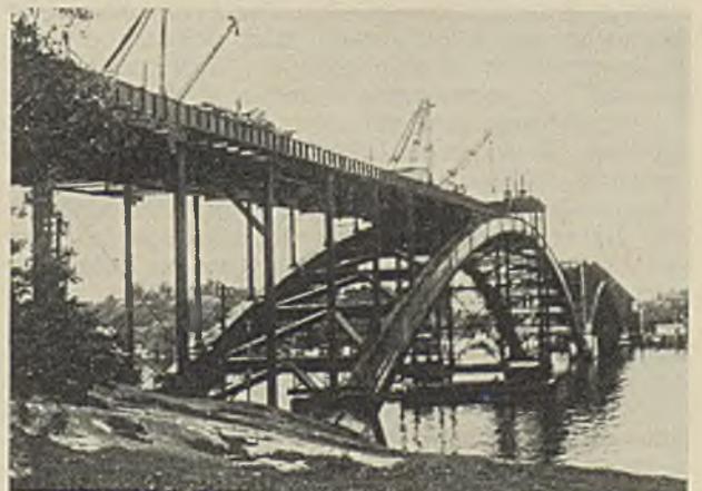
Abb. 7. Aufstellen der Aufbauten der linken Bogenöffnung nach Fertigstellung der rechten Öffnung.
