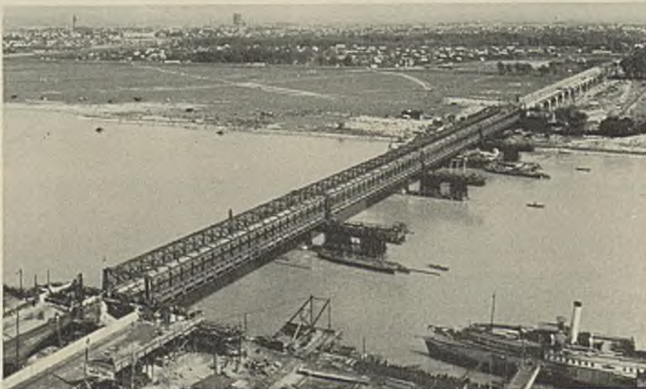
Abb. 1. Die Reichsbrücke während der Verschiebung.
