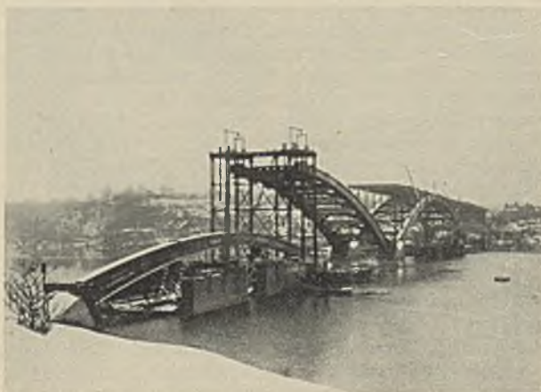
Abb. 6. Einschwimmen der linken Bogenhälfte, die rechten Hälften am Gerüst aufgehängt.
