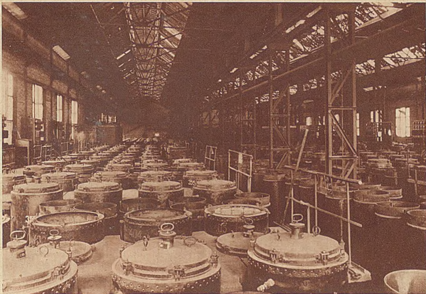
Chorzów. Fabryka związków azotowych: piece azotowe.
