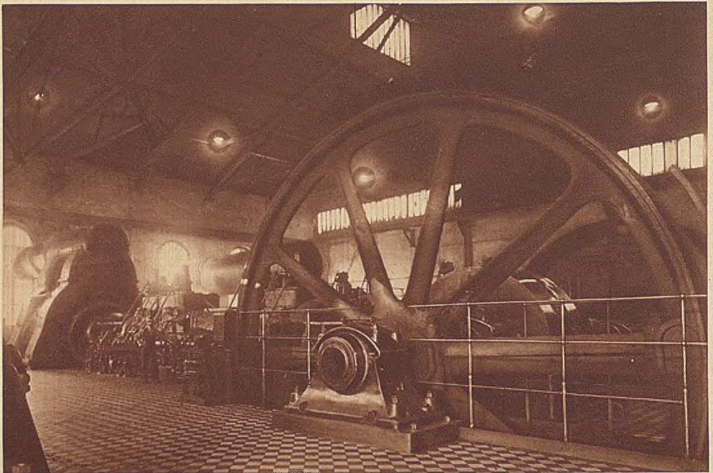
Huta Pokoju w Nowym Bytomiu. Siłownia do napędu walcowni.
