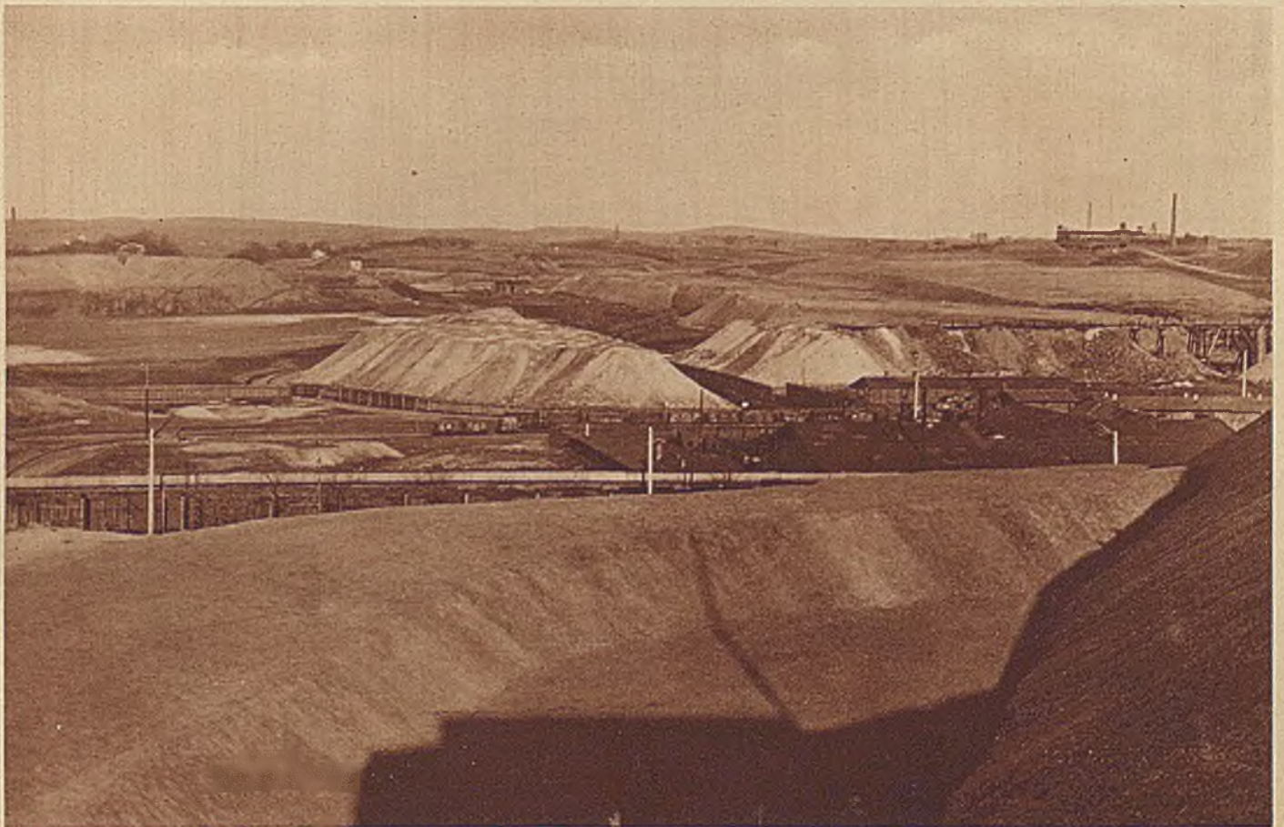
Szarlej (Górny Śląsk). Ogólny widok kopalni rud cynkowych.
