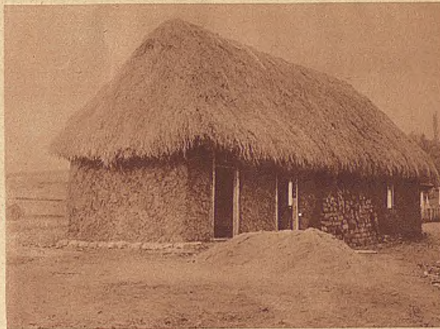
5. Lepianka w budowie, wieś Kałaharówka nad Zbruczem. Fot. S. Zwierz
