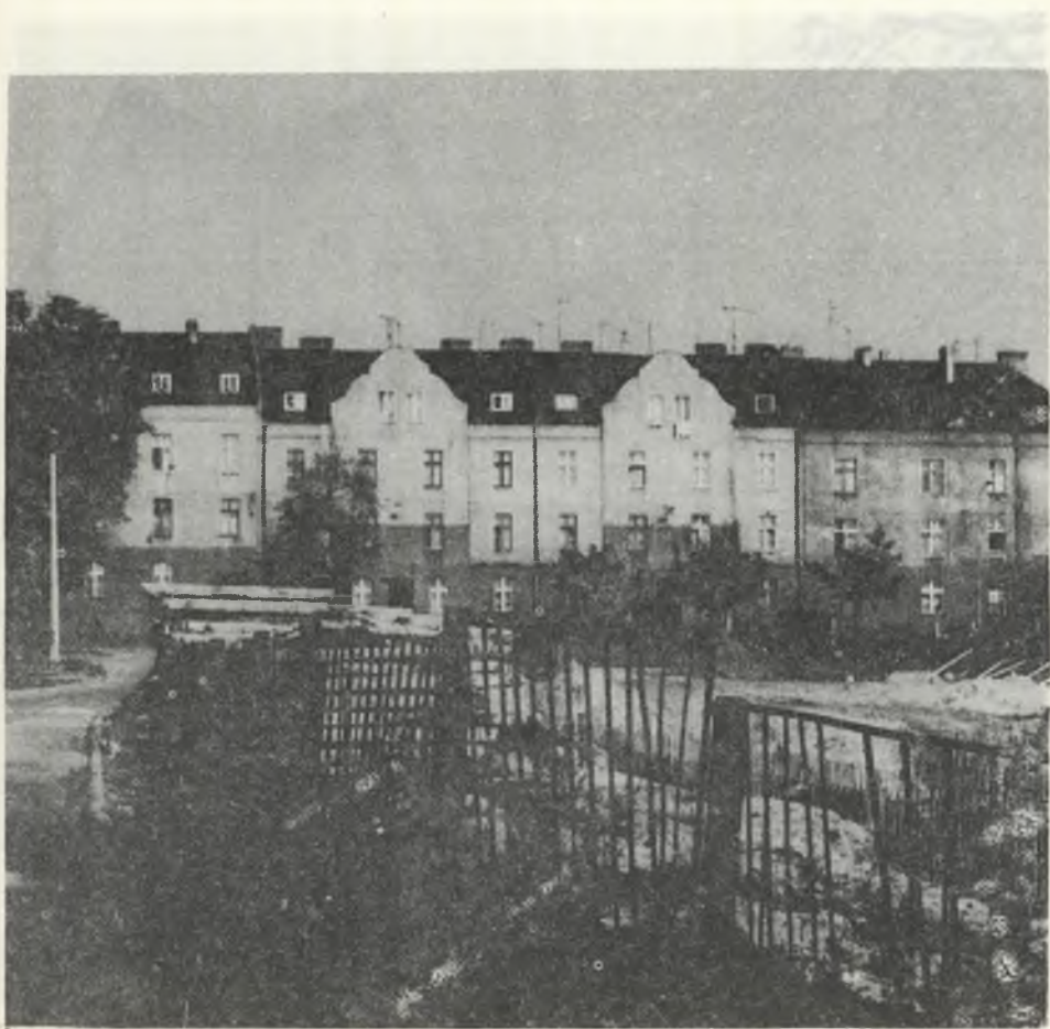
Rys. 8. Ulica Św.Marka, pierzeja północna, budynki (nr 20,22,24)
