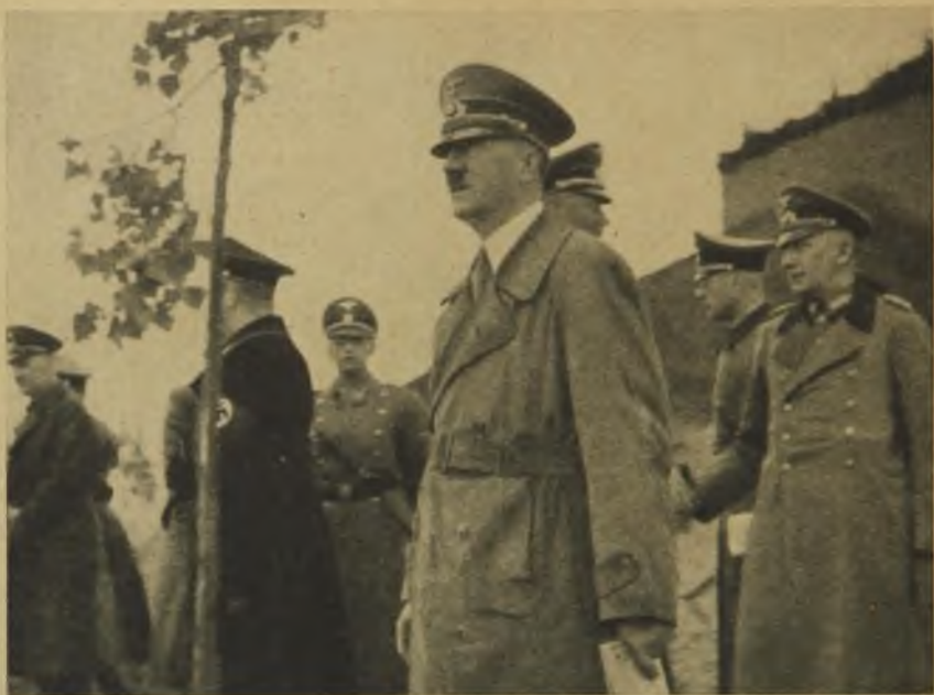
Der Führer bei der Besichtigung des Westwalls im Mai 1939. Ganz rechts der Oberbefehlshaber der den Westen des Reiches beschirmenden Truppen, General d. Infanterie v. Witzleben.
