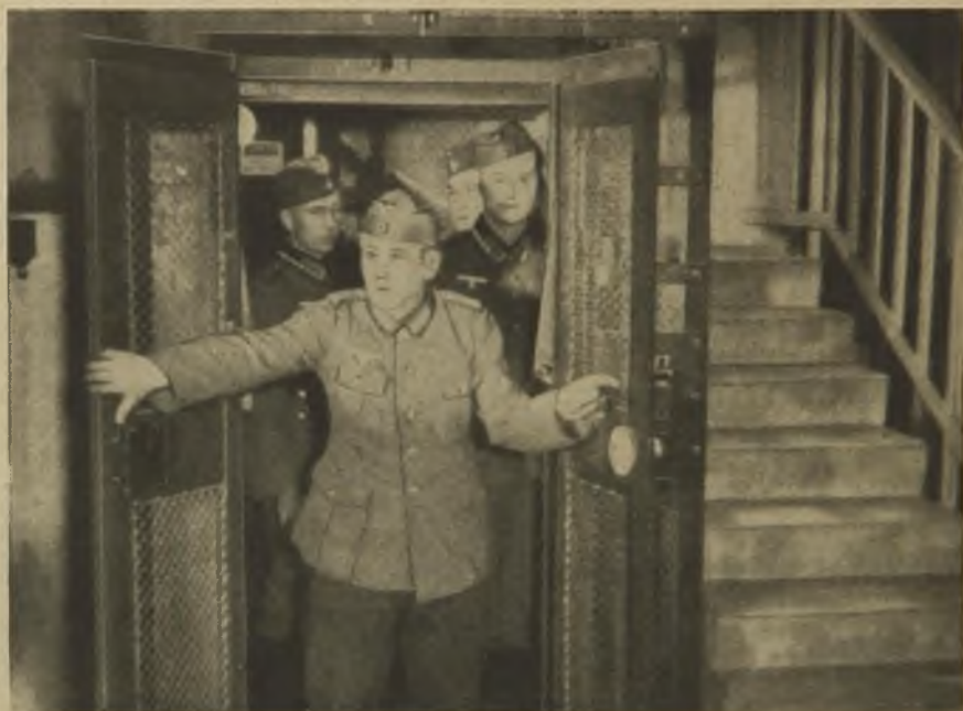
Fahrstühle verbinden die verschiedenen Stockwerke der Panzerwerke.
