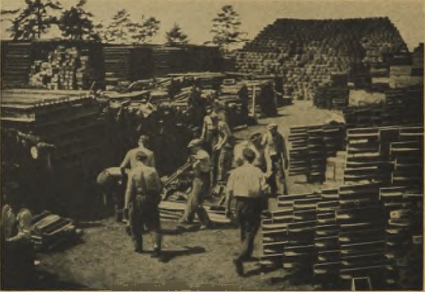
Riesige Lagerplätze entstanden in allen Abschnitten der Befestigungszone. Im Hintergrund haushohe Stapel von Stachelbraht für die Herstellung von Infanteriehindernissen.
