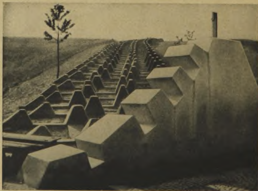
An den Straßen, die im Frieden für den Verkehr offen bleiben müssen, sind Sperren vorbereitet. Sie werden erst im Ernstfalle durch schwere Träger geschlossen.
