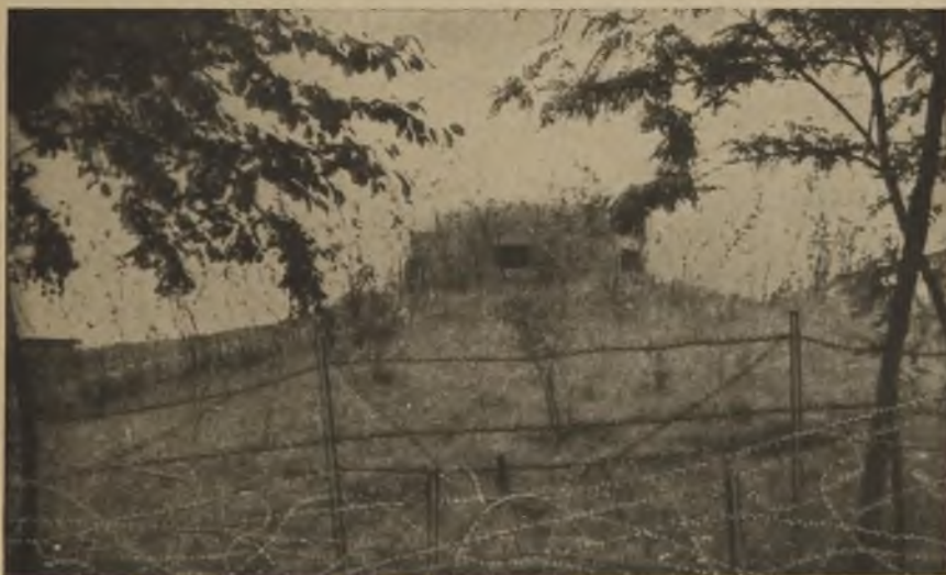
Die Panzerwerke bieten nur kleine, schwer zu findende und zu treffende Ziele. Der größte Teil des Werkes liegt tief unter der Erde. Nur die Panzertürme ragen, sorgfältig getarnt, daraus hervor und beherrschen mit dem Abwehrfeuer ihrer Waffen in weitem Umkreis das Gelände.
