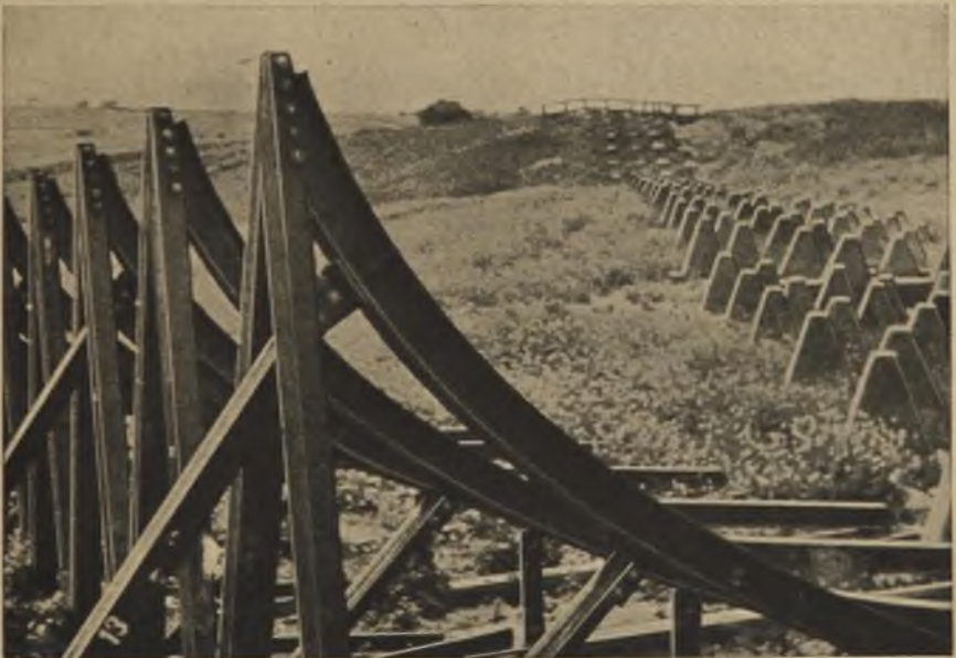
In wichtigen Abschnitten sind die Höckerhindernisse durch Hemmkurvenhindernisse verstärkt.
