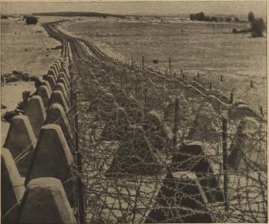
Kilometerweit ziehen sich die schweren Höckerhindernisse, die jeden Kampfwagenangriff aufhalten, durch das Land. Das Infanteriehindernis ist hier in das Höckerhindernis hineingebaut.
