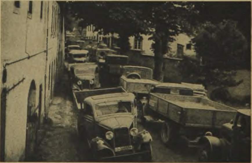
Mehr als 15000 Lastkraftwagen beförderten die Baustoffe an die Baustellen. Die Verkehrsregelung in den engen Dorfstraßen erforderte einen verstärkten Einsatz von Polizei und NSKK.
