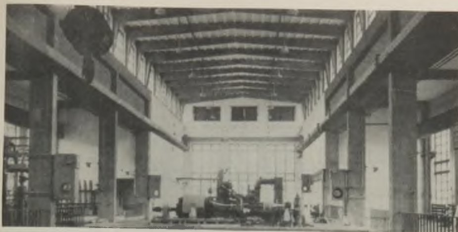
Wnętrze hali technologicznej Wydziału Mechaniczno-Energetycznego
