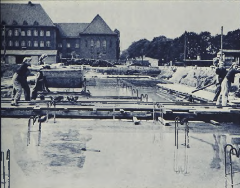
BUDOWA GMACHU WYDZIAŁU INŻYNIERYJNO-BUDOWLANEGO W 1949 R. (OBECNIE WYDZIAŁ BUDOWNICTWA I ARCHITEKTURY)
