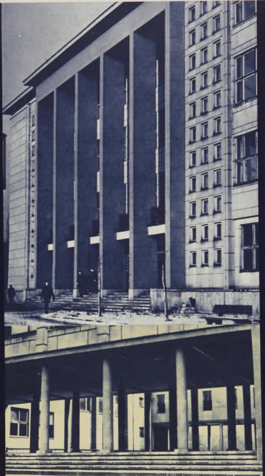
GMACH WYDZIAŁU BUDOWNICTWA I ARCHITEKTURY (AUTOR: ARCH. T.T. TODOROWSKI)
