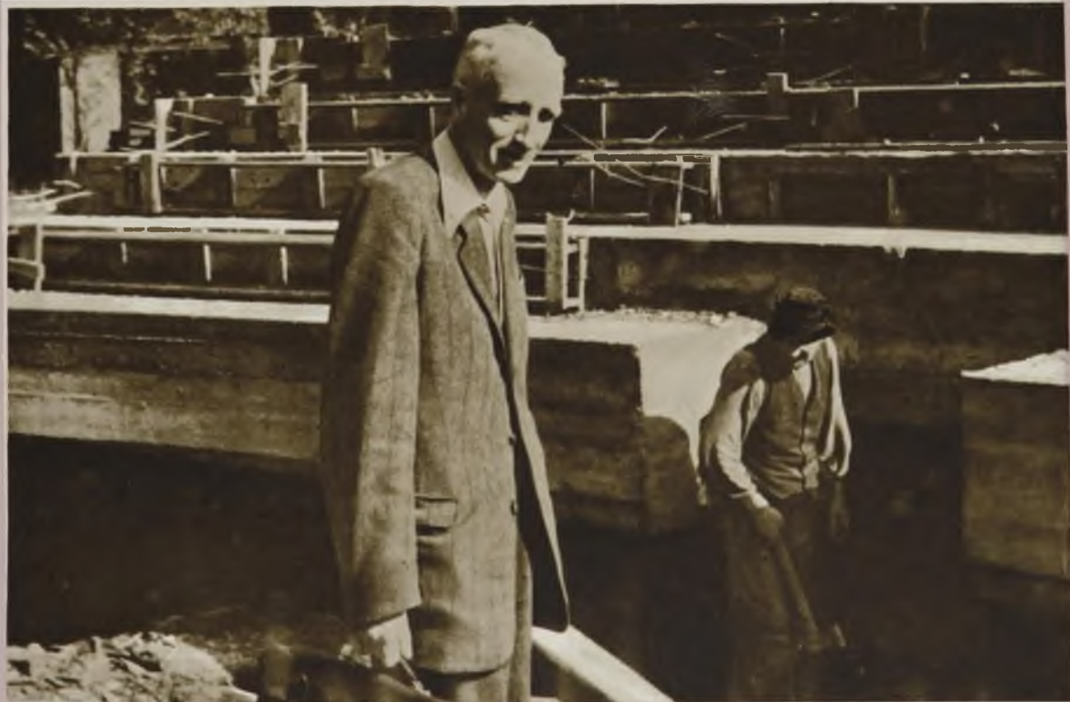
PROF. DR. INŻ. WIKTOR JAKÓB NA BUDOWIE AUDYTORIUM WYDZIAŁU CHEMICZNEGO
