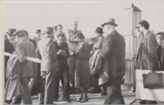
Początki budowy dzielnicy akademickiej
