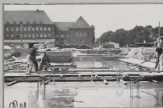
Budowa Wydziałów Politechniki Śląskiej: Budowlanego i Górniczego
