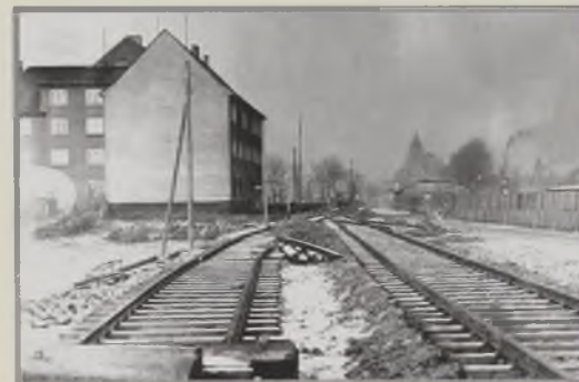
Bocznicę kolejową przy Politechnice – dowożenie materiałów budowlanych koleją
