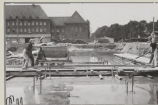
Budowa Wydziału Budownictwa
