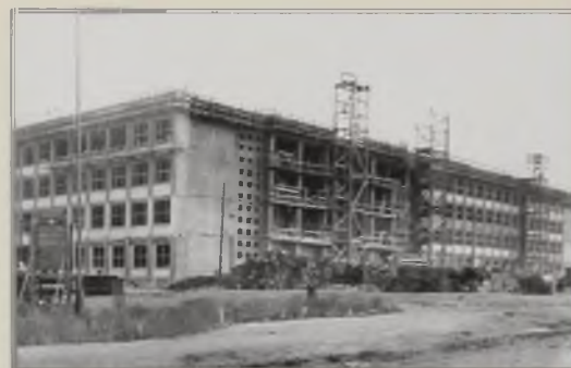
Budowa Wydziału Budownictwa
