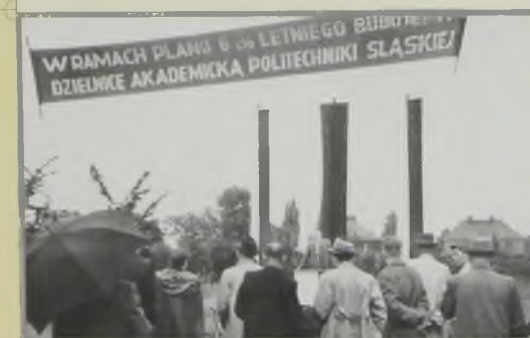
Początki budowy dzielnicy akademickiej
