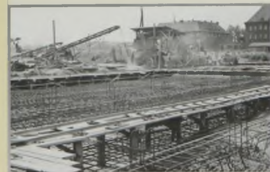
Budowa Wydziału Budownictwa
