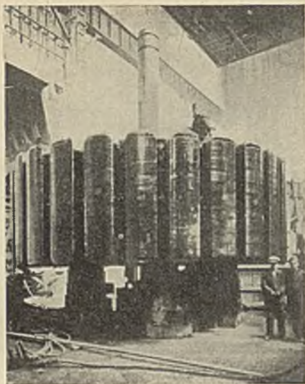
A. WIRNIK (POLE) WIELKIEJ PRĄDNICY (65 000 KVA) zakładu wodno-elektrycznego przy Niagarze
