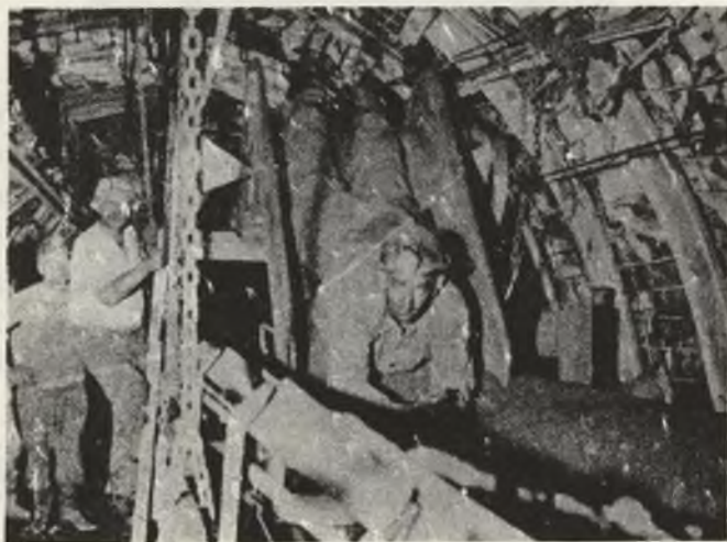
Rys. 7. Peron nad przenośnikiem
