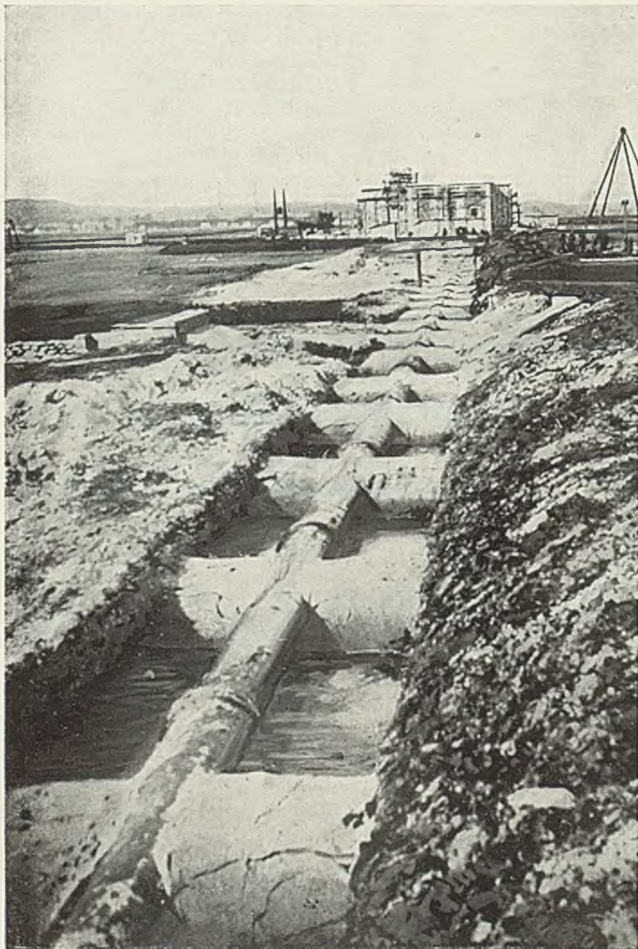
GDYNIA. RUROCIĄG LEWAR UŁOŻONY NA PROGACH BETONOWYCH CO ZAPEWNIĄ SZCZELNOŚĆ POŁĄCZEŃ.
