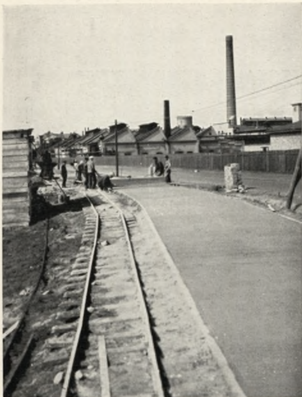
Herstellung eines Radfahrweges mit Stampfbohle. Bitterfeld-Zörbig
