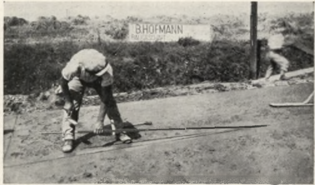
9. Die 2 cm hohe hölzerne Fugenleiste wird gezogen
