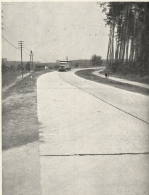
Reichsstraße Dessau—Leipzig mit Betonradfahrweg
