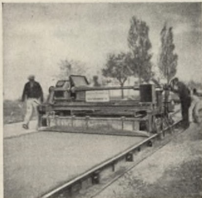
Der Thiele-Vibrator beim Bau einer Reichsstraße
