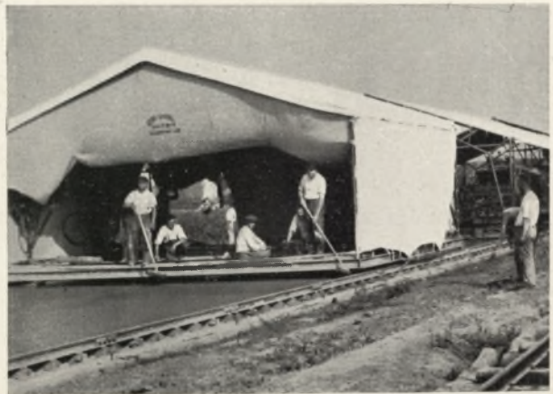
Allseitig abgeschlossene Arbeitsbühne
