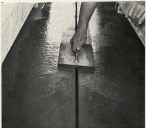
Beidseitiges Glattstreichen längs der Fuge
