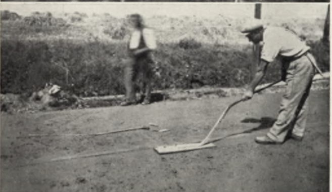
8. Der Feinbeton wird an den Fugenkanten nachgestampft und abgerieben
