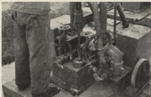
Ausbohren eines Bohrkernes
