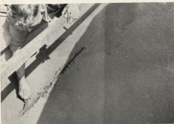
Sorgfältiges Entfernen der Betonschicht über der Fugeneinlage
