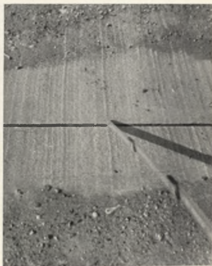
Im erhärteten Beton eingegchnittene Fuge
