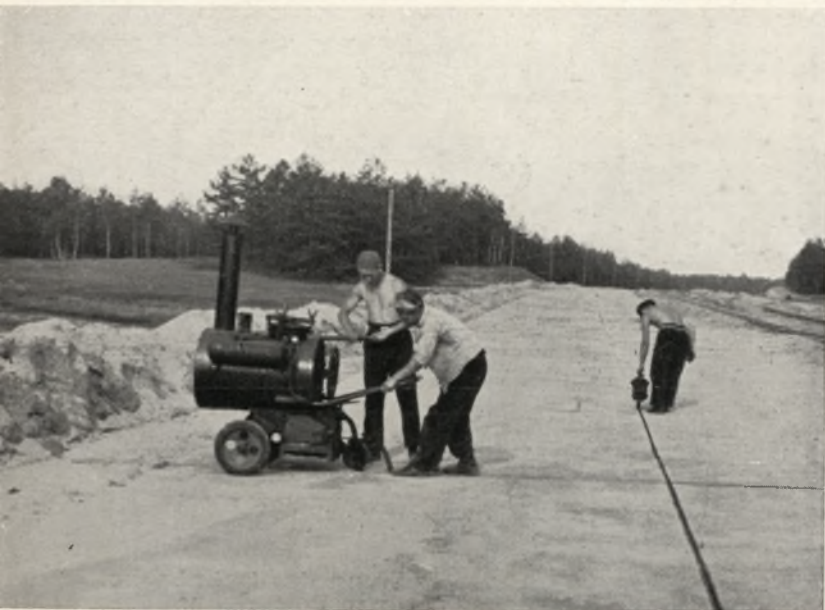
Fugenverguß mit Einpreßgerät und von Hand
