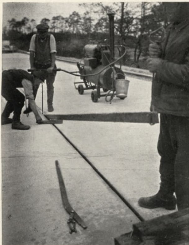
Ziehen eines Wieland Eisens unter Dampferhitzung
