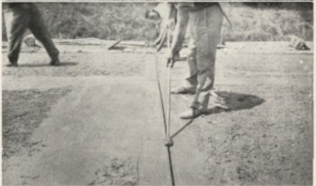
11. Die Kanten einer Quertuge werden nachgebügelt und abgerundet
