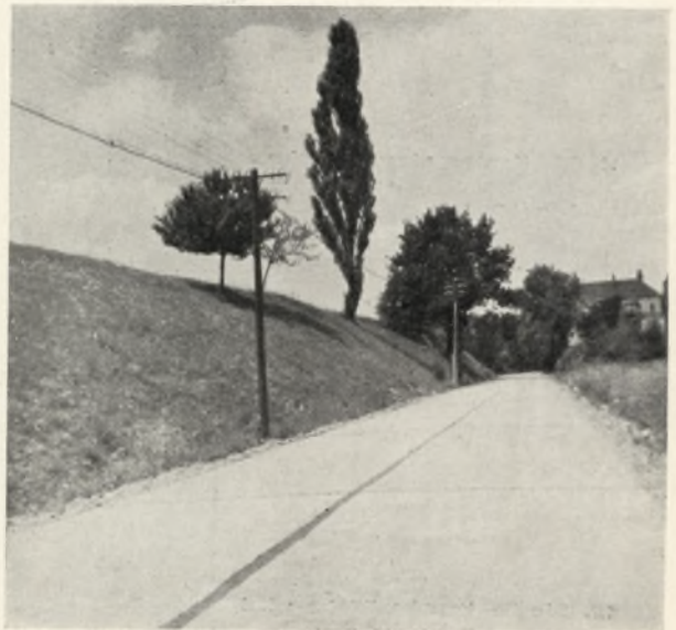
15. Zementschotterdecke bei Bruchenbrücken, Kreis Friedberg (Oberhessen)
