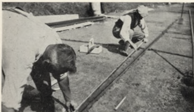
5. Auf die Holzfaserplatte wird eine 2 cm hohe Holzleiste aufgesetzt
