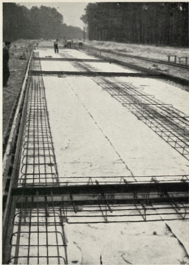
Umlaufende Bewehrung aus räumlichem Baustahlgewebe und Verdübelung
