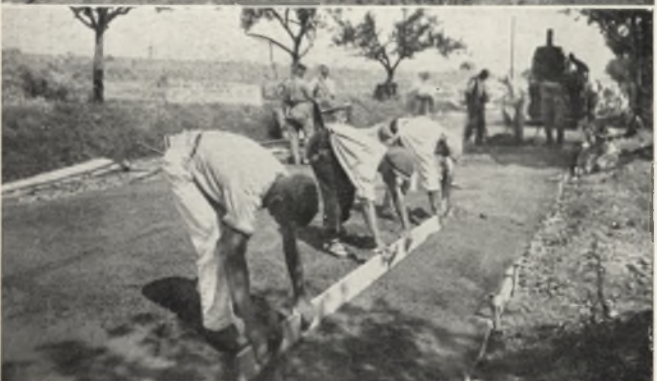
7. Nachdem die Fugen fertig beigestampft sind, wird die Decke mit Feinbeton (Mörtel) abgezogen
