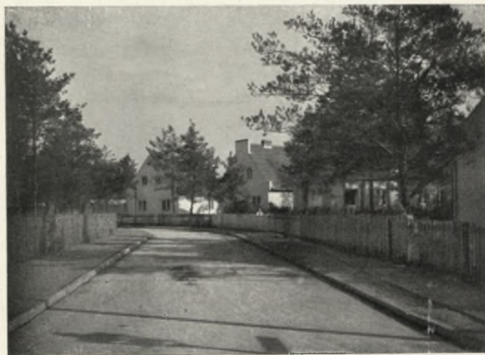
Betonstraße in Siedlung Klein-Machnow b. Berlin
