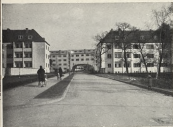
Betonstraße in Berlin-Siemensstadt Ausf. : Philipp Holzmann A. G.
