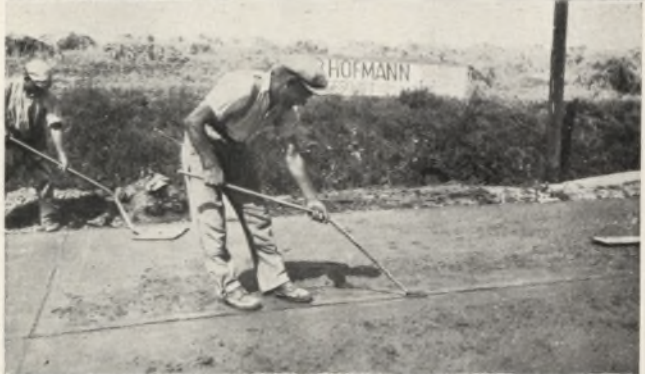
10. Die Kanten der Längsfuge werden nachgebügelt und abgerundet
