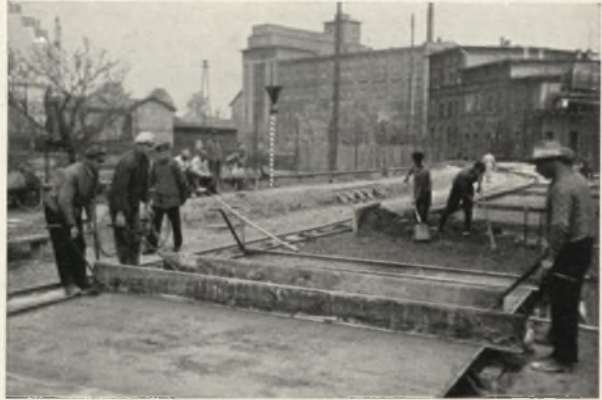
Verdichten durch Stampf- bohlen in der Querrichtung
