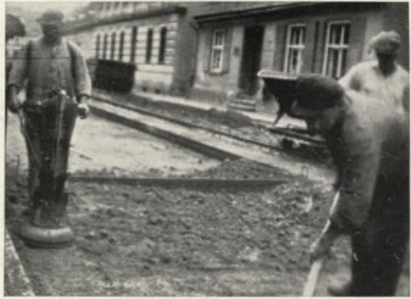
Verdichten des Unterbetons
