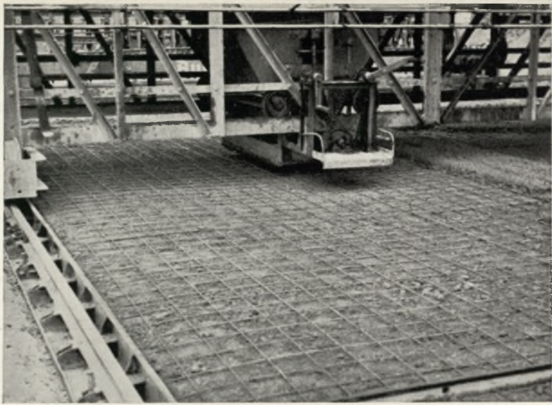
Bewehrung mit Baustahlgewebe Eiserne Schalungs- schienen (Krupp)
