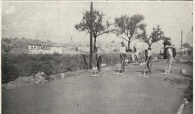
12. Die Deckenoberfläche wird plane abgerieben
