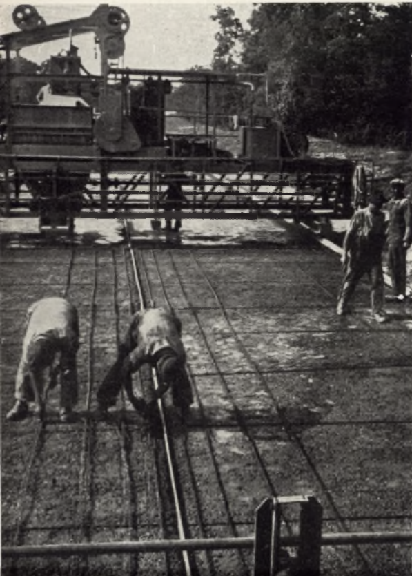
Bewehrung mit Istegstahl (engere Lagen an den Rändern)
