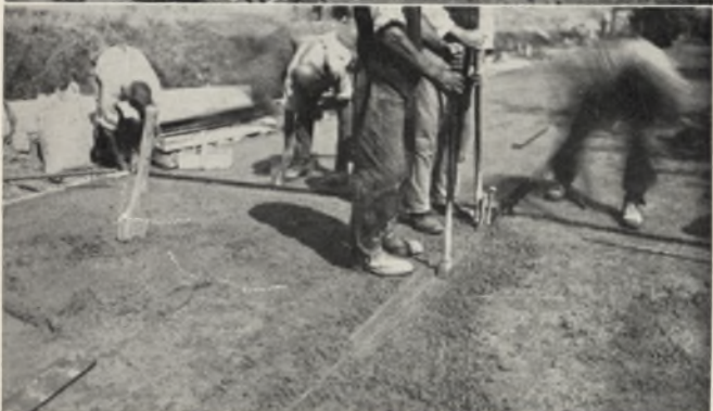
6. Nach Einsetzen der Fugenkörper wird die Fugenrille mit Feinbeton ausgestampft
