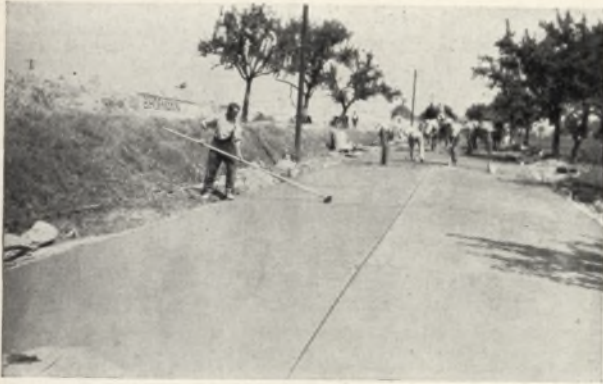
13. Die fertige Deckenoberfläche wird zum Schluß mit einem Haarbesen leicht geriffelt
