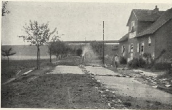
14. Nachbehandlung der Decke durch Abdecken mit Erde und Naßhalten
