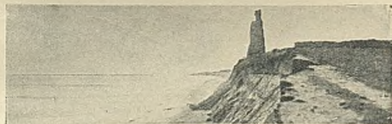
D. Jedyna ściana pozostała po wieży kościelnej w 1919 r.
