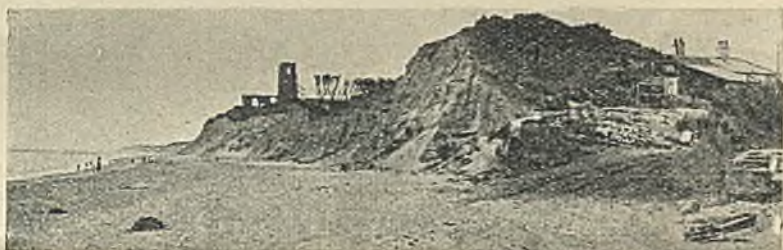
C. Ten sam kościół w 1914 r.; widać, że znikło urwisko i część budowli.
