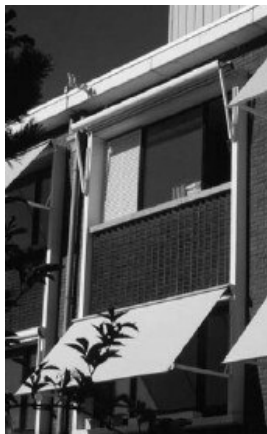
Rys. 6.65. Uchylne okna w budynku PROBE
