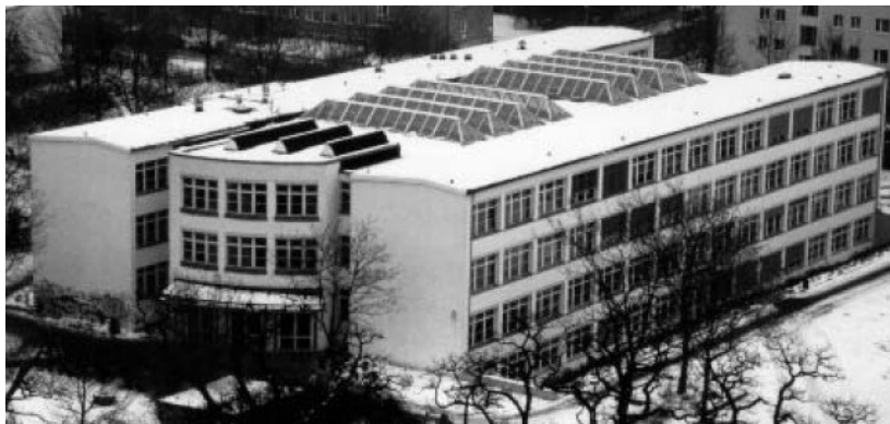
Rys. 6.70. Widok ogólny budynku
