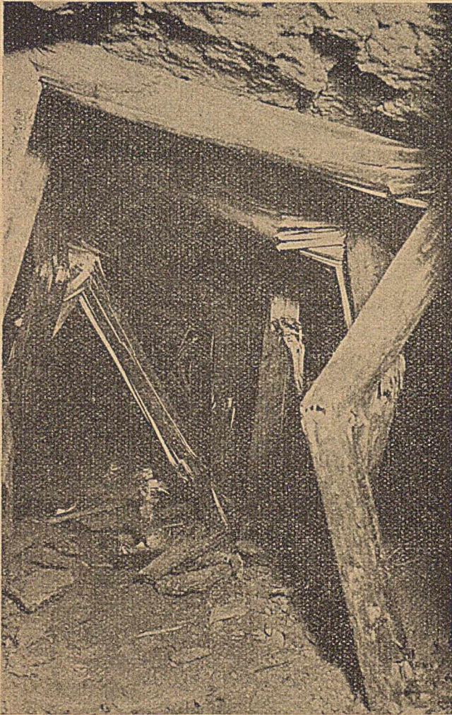
KOPALNIA KAŁUSZ: Wyeksplcatowany i zniszczony chodnik
