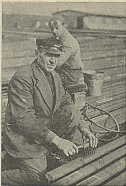
Rys. 115. Przygotowanie do naprawy szyn rakowatych.
