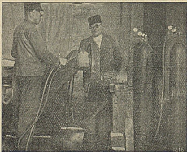
Rys. 6. Napawanie acetylenowe osi parowozowej w Warsztatach Kolejowych we Florencji (Włochy).
