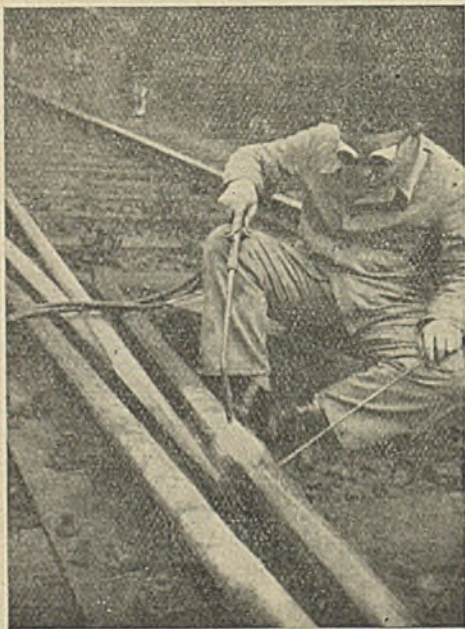
Rys. 113. Napawanie krzyżownicy w torze.
