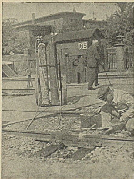
Rys. 114. Napawanie styku w torze.
