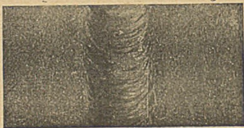
Rys. 21. Widok spoiny wielkości naturalnej, wykonanej metodą „w górę”, przez 2-ch spawaczy, z ukosowaniem krawędzi na blasze grub. 16 mm.
