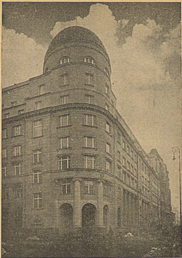
Gmach P. K. O. w Warszawie przy ul. Świętokrzyskiej. 700 tonn konstrukcji całkowicie spawanej zostało wykonane przez Sp. Akc. Perun. Była to pierwsza budowla spawana w Europie tej wielkości. Dla upamiętnienia tej pionierskiej pracy Sp. Akc. Perun wydała Album, zawierający opis konstrukcji wraz ze 132 zdjęciami zaopatrzonej w studjum prof. S. Bryły o projektowaniu i obliczaniu konstrukcji spawanych.
