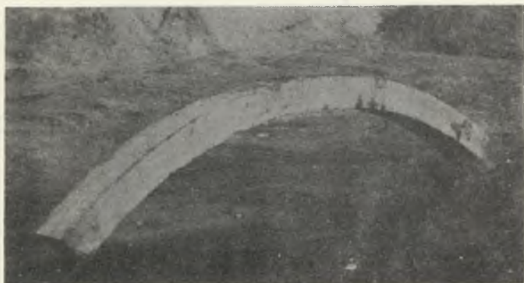
Rys. 14. Widok pojedynczego elementu żelbetowej obudowy pierścieniowej
