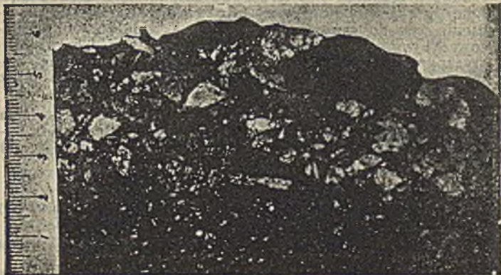
Beton smołowy na warstwie wiążącej z grysu smołowanego.
