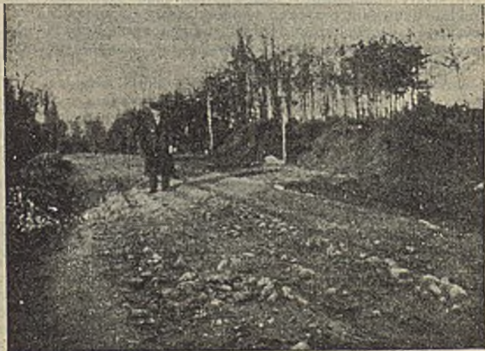
Przełomy na nawierzchni tłuczniowej Widoczne elementy podkładu kamiennego.
