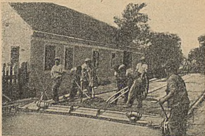
Wibrator listwowy z elektrycznym napędem. Szerokość 2 — 3 m.
