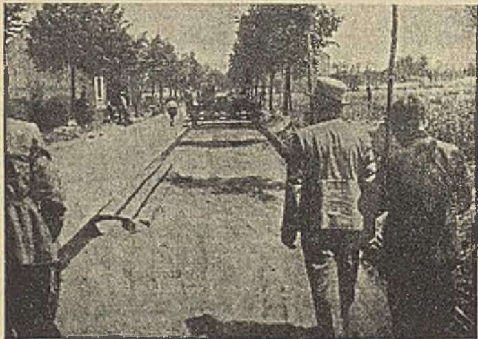
Betonowanie na połowie szerokości drogi.
