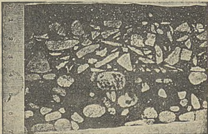
Beton asfaltowy z warstwą asfaltu płaskowego na warstwie wiążącej żwirowej.
