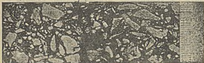
Asfalt lany żwirowy.
