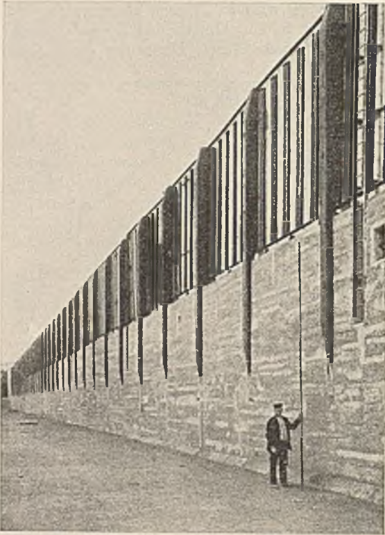
Abb. 557. Kammerwände der Hemelinger Schleuse. Bremen. Betonverkleidete Spundwände.
