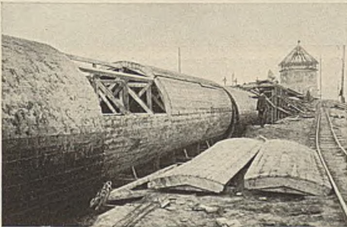
Abb. 484. Schalung des Eisenbetondruckrohres des Radaunwerkes bei Danzig.
