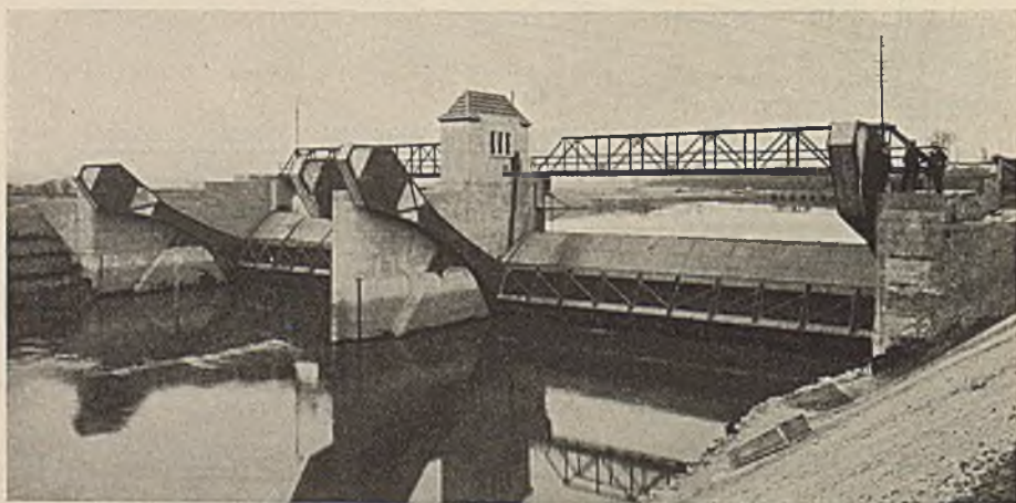
Abb. 400. Segmentwehr nach dem System Louis Ellers, Hannover, bei 22 m Lichtweite, 6 m Höchststau; einseitiger Antrieb.
