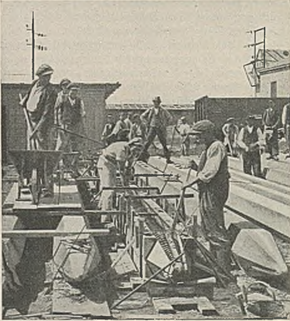
Abb. 126. Einbringen des Betons in die liegenden Formen.
