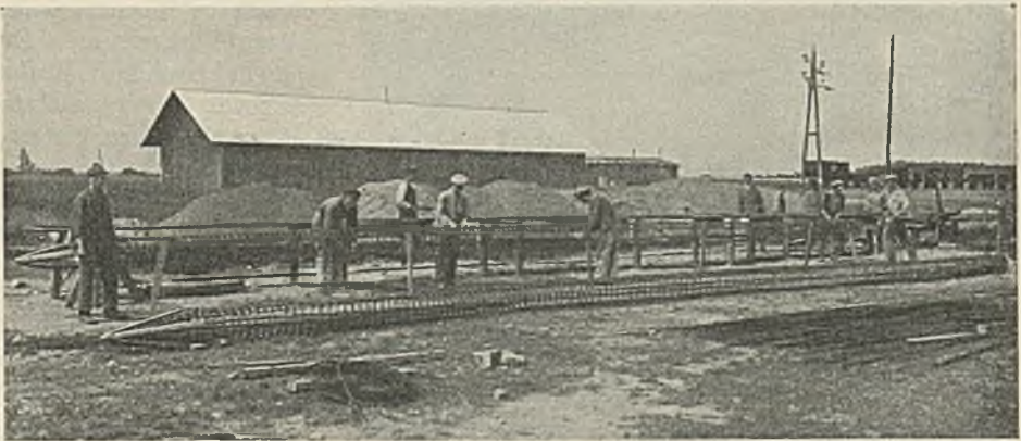
Abb. 125. Herstellung der Eisenarmierung.
