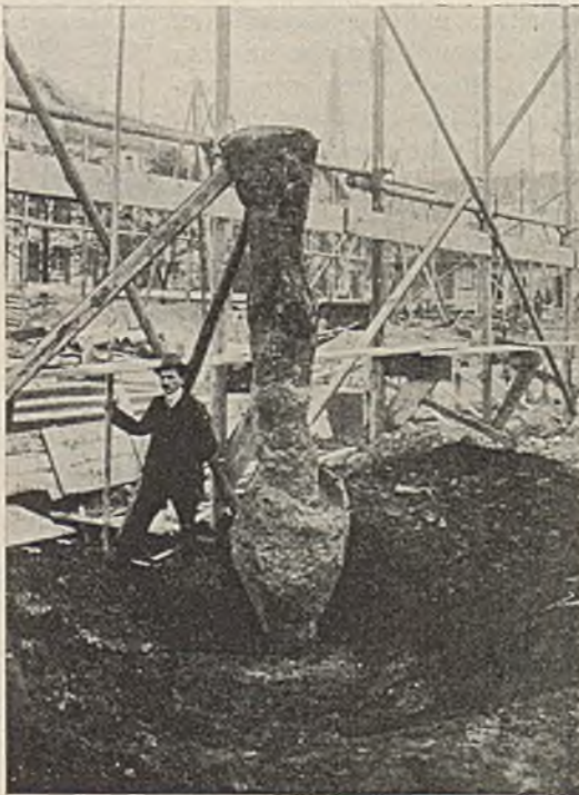
Abb. 87. Ausgegrabener Straußpfahl.
